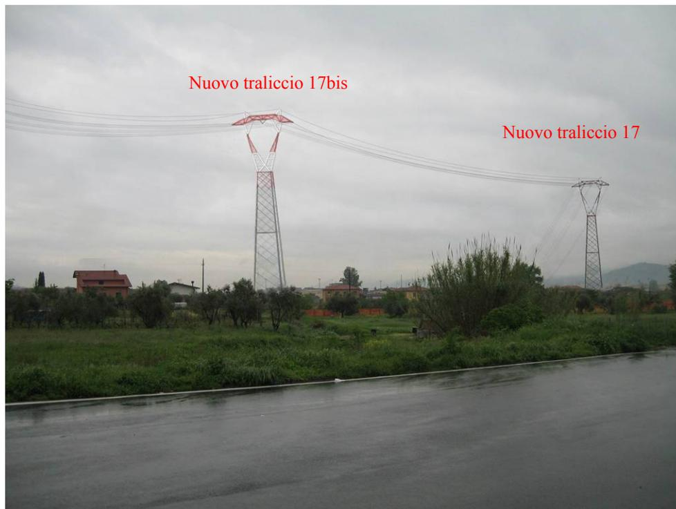
*Fig. 4.12 b – Simulazione con nuovi tralicci 17 e 17bis e innalzamento dei conduttori*
