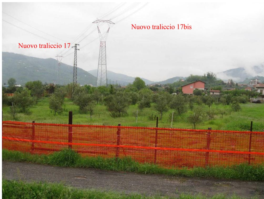
*Fig. 4.13 b – Simulazione con nuovo traliccio 17bis e innalzamento dei conduttori*
