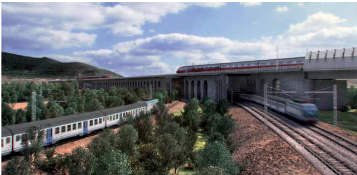
Figura 2-7: VI01 “Struttura ad archi”
