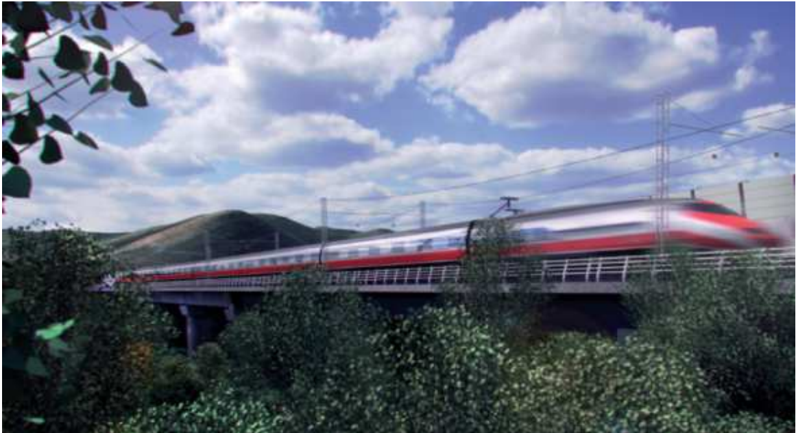
Figura 2-4: VI07 Viadotto Isclero
