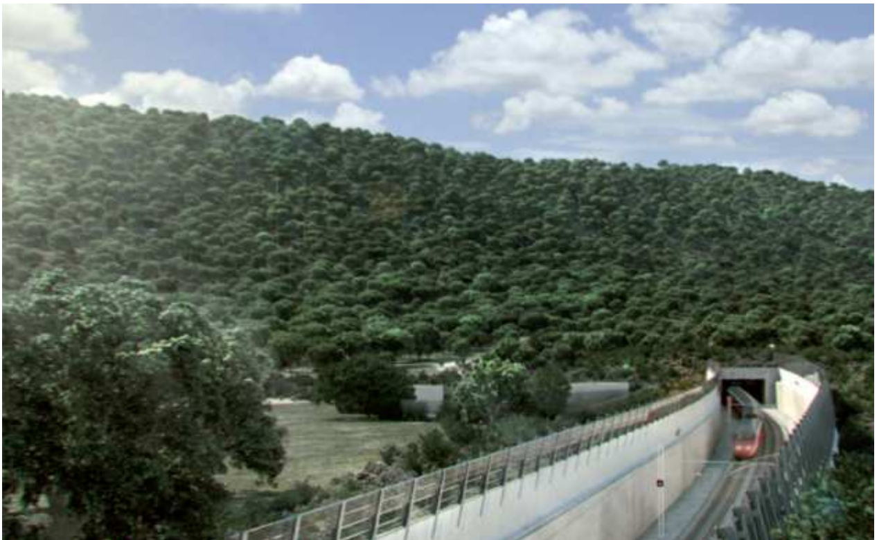
Figura 2-3: Imbocco Nord della Galleria Monte Aglio
