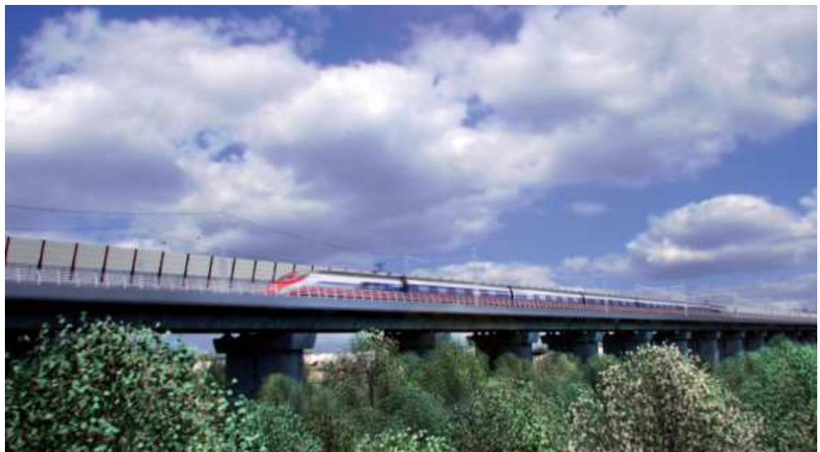
Figura 2-5: VI06 Viadotto San Michele
