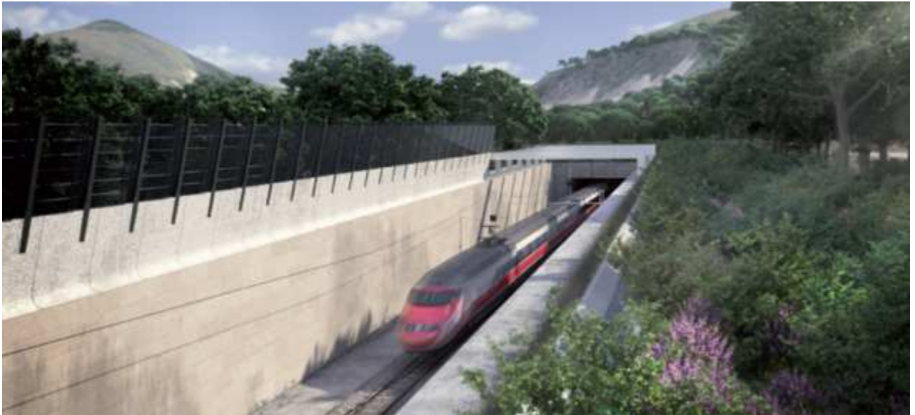
Figura 2-2: Imbocco Sud della Galleria Monte Aglio
