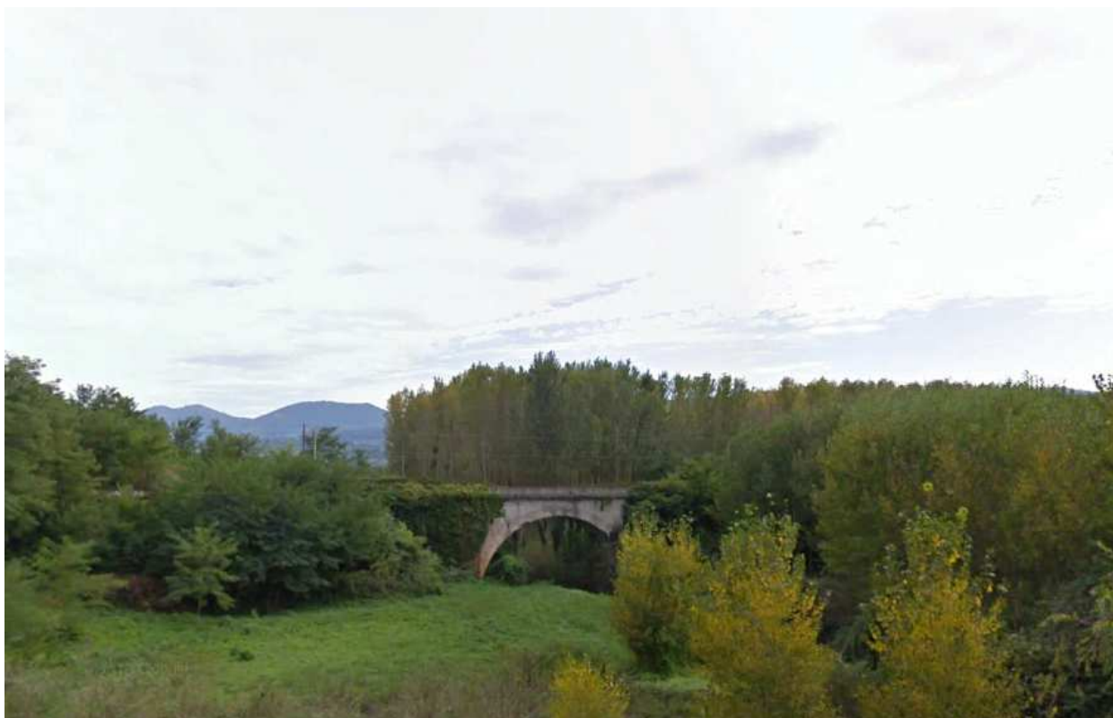
Figura 9-1: Vegetazione in prossimità dell'attuale viadotto sul fiume Isclero
