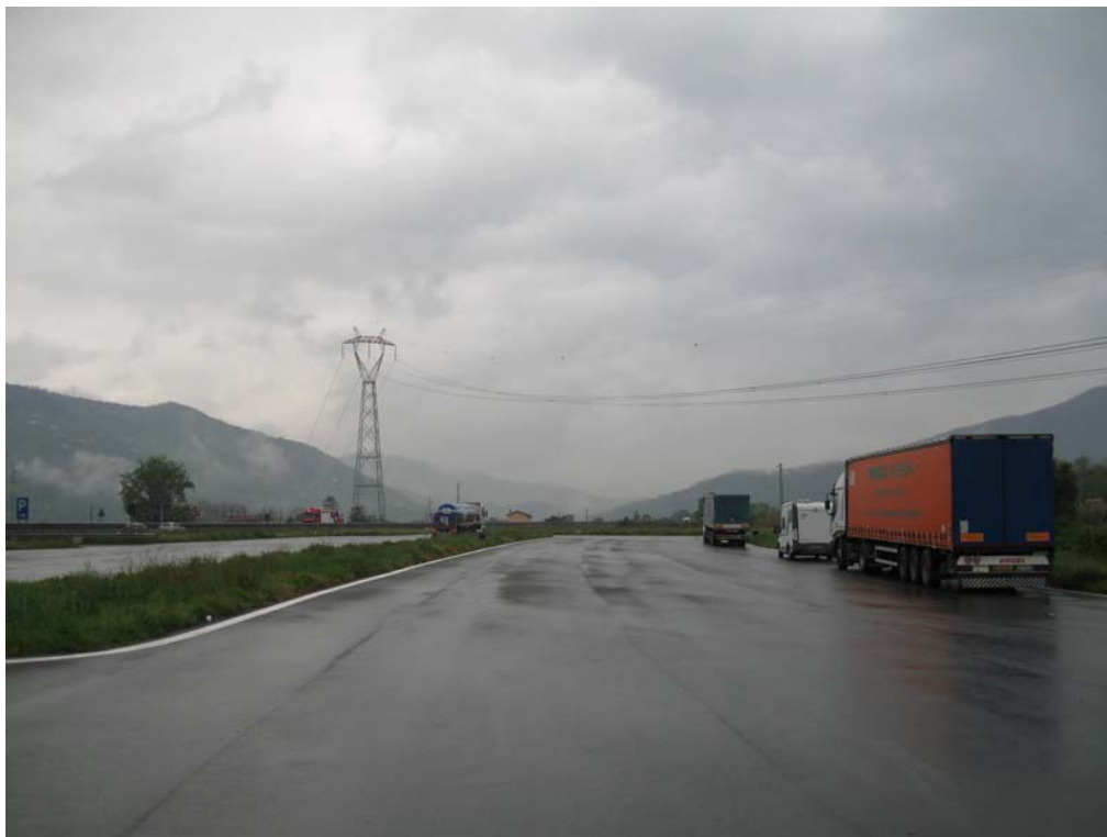
Fig. 4.10 - L'autostrada della Cisa attraversata dall'elettrodotto e, sullo sfondo, il traliccio 18.
