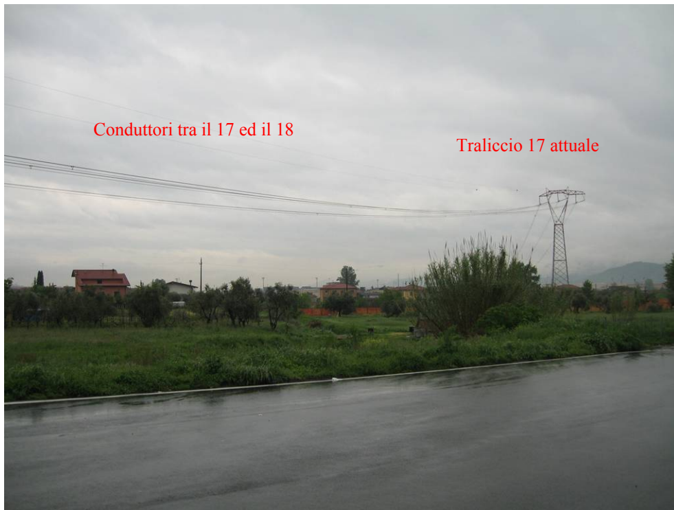
Fig. 4.12 a – Attuale traliccio 17 ed i conduttori verso il traliccio 18
