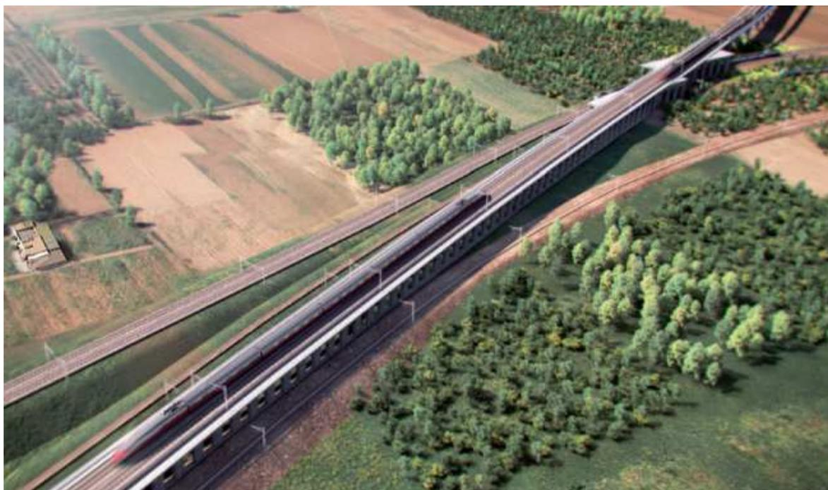
**Figura 2-6: Struttura ad Archi – collegamento scalo Marcianise**
