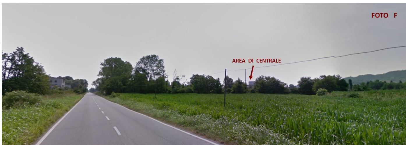
Figura 9.1-4: vista della Centrale dalla SS 31 bis
