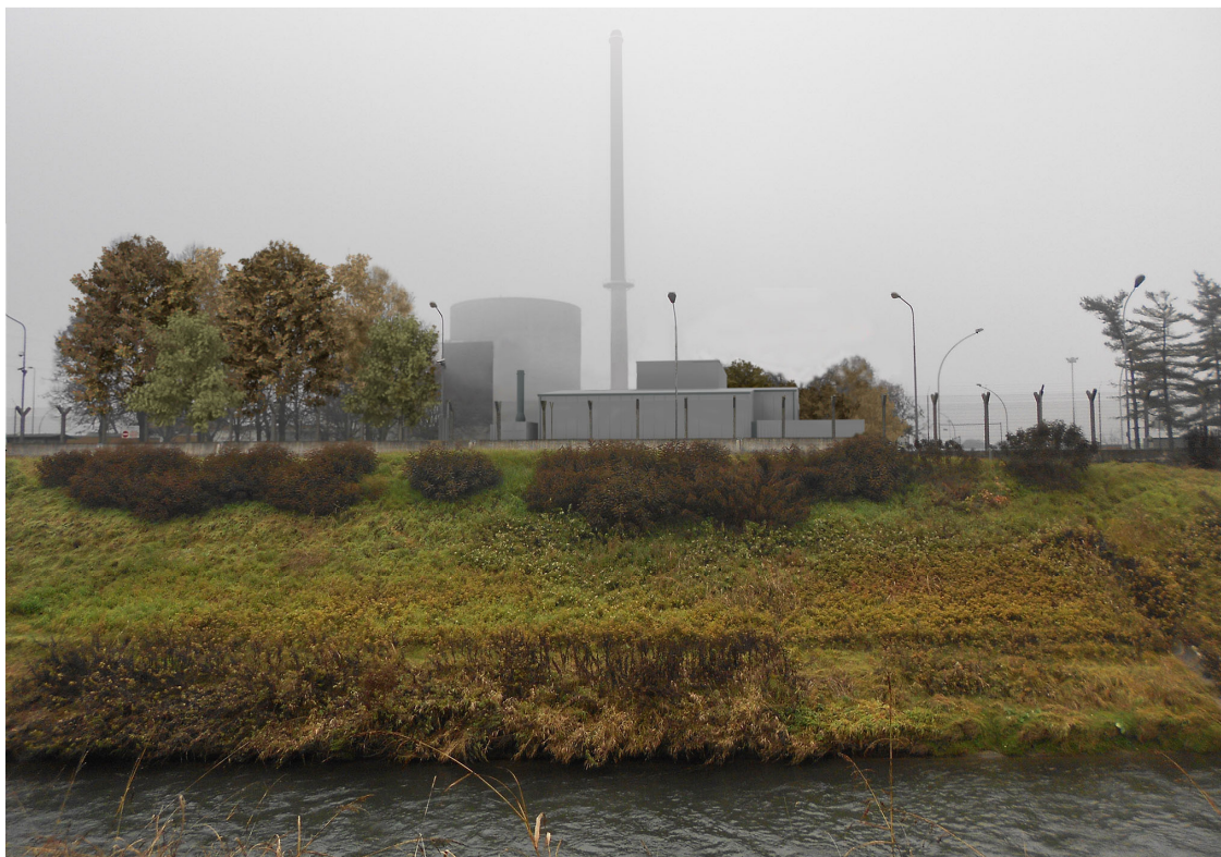
Figura 10.3-2: Area di intervento a edificazione dell'impianto SiCoMoR completata
