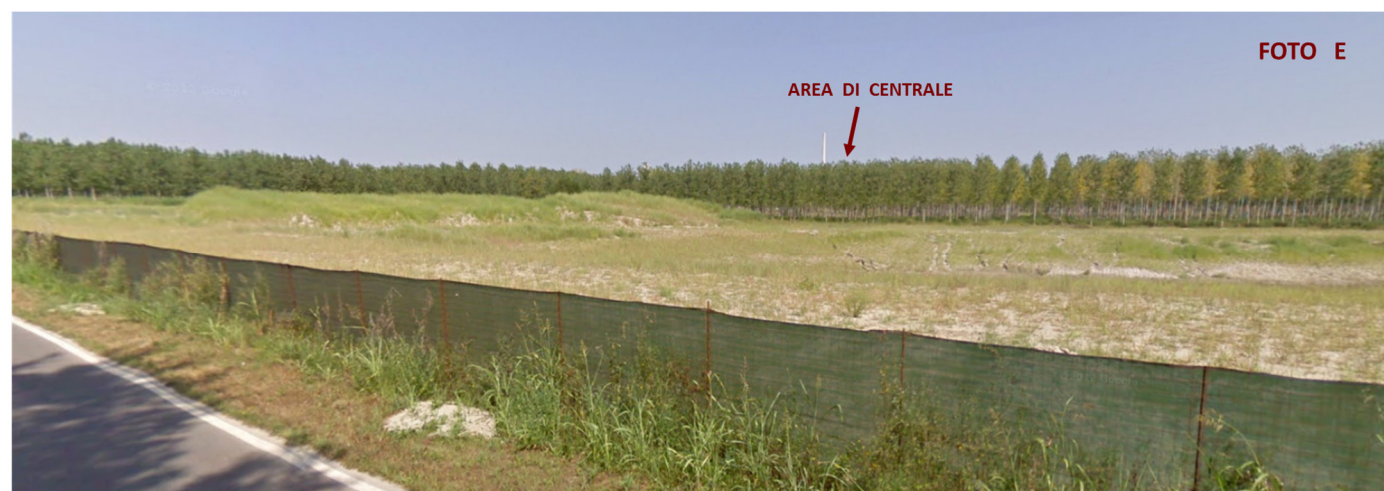
Figura 9.1-7: vista della Centrale da Via Vittorio Emanuele (riva destra Po)
