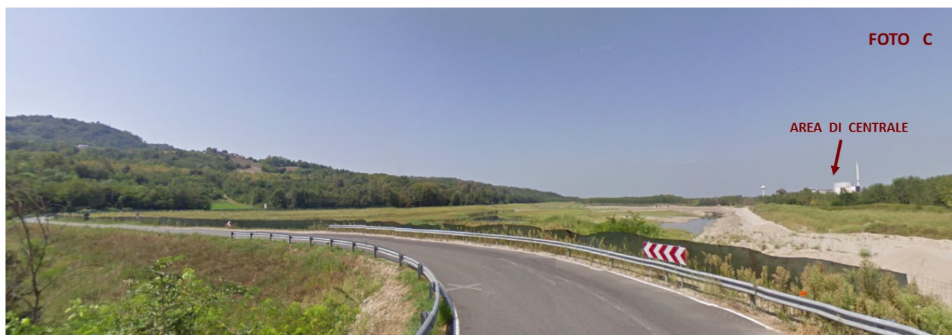
Figura 9.1-5: vista della Centrale da Via Vittorio Emanuele (riva destra Po)
