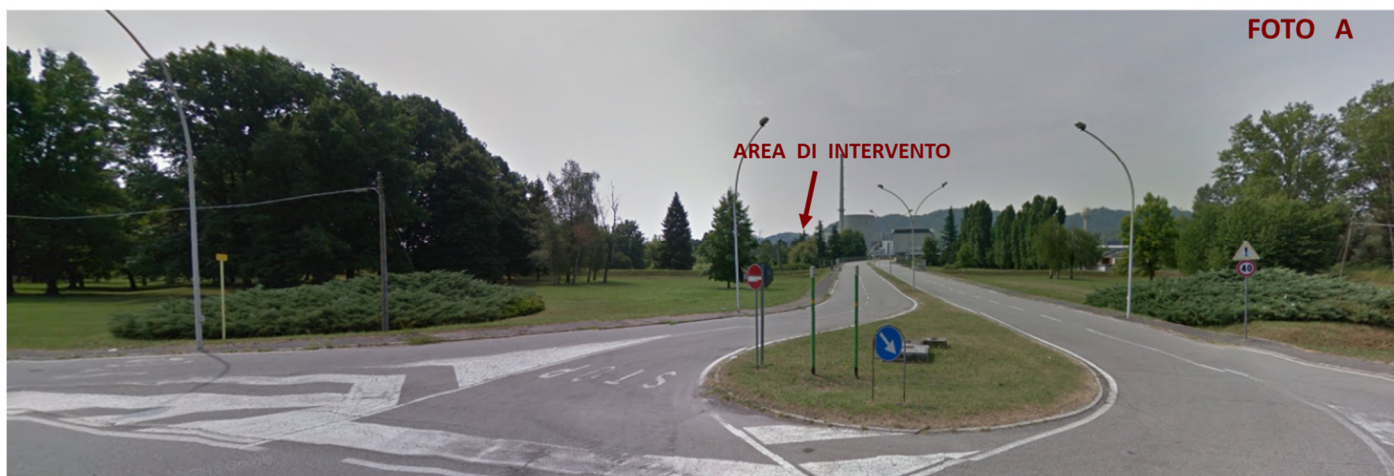
Figura 9.1-2: vista della Centrale dalla strada di accesso
