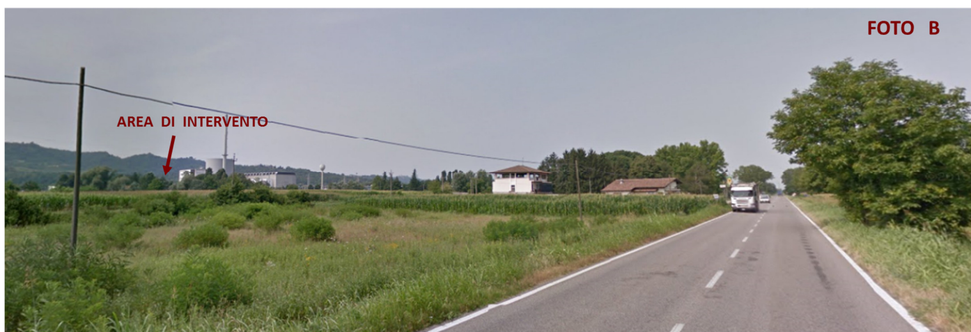
Figura 9.1-3: vista della Centrale dalla SS 31 bis
