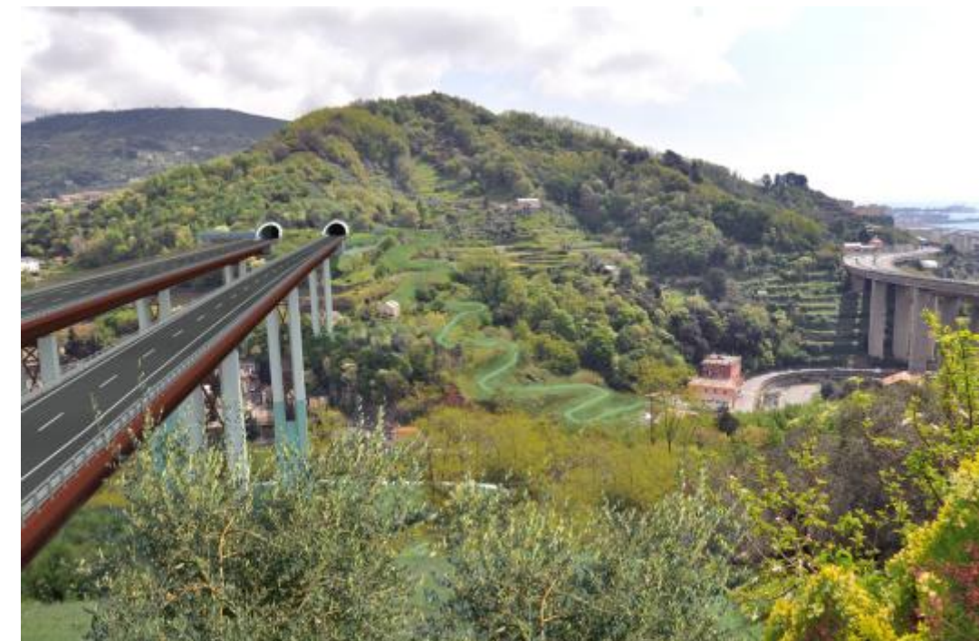
Figura 11 – Viadotti Leiro – Fotoinserimento – Crescita della vegetazione, Variante colorazione opere: parte piena delle pile in grigio-verde
