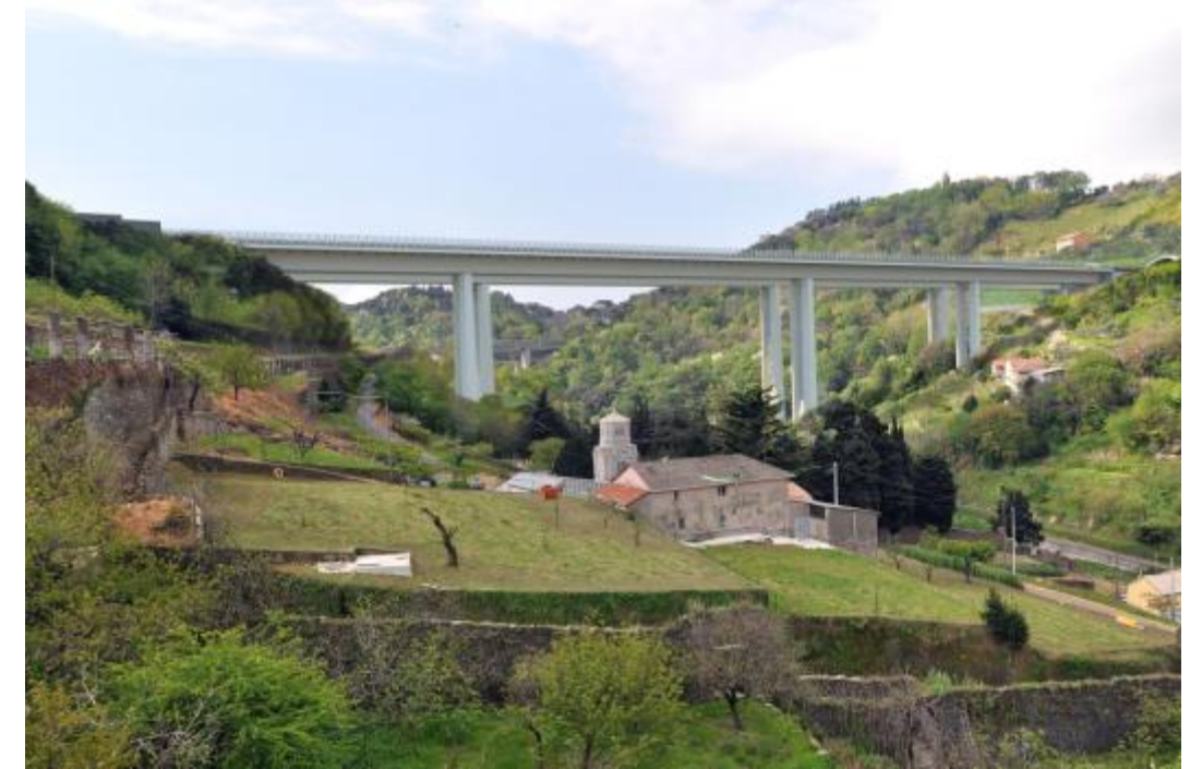
Figura 18 – Viadotti Leiro – Fotoinserimento – Crescita della vegetazione, Variante colorazione opere: tralicciatura pile, impalcato e barriere in "greige"
