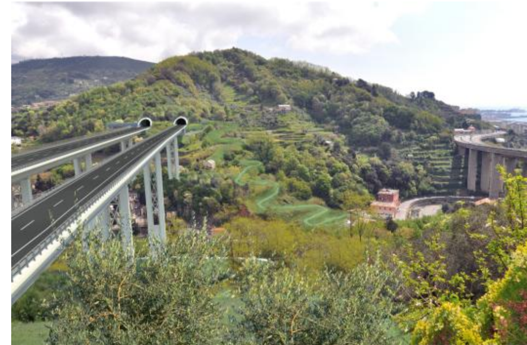
Figura 10 – Viadotti Leiro – Fotoinserimento – Crescita della vegetazione, Variante colorazione opere: tralicciatura pile, impalcato e barriere in "greige"
