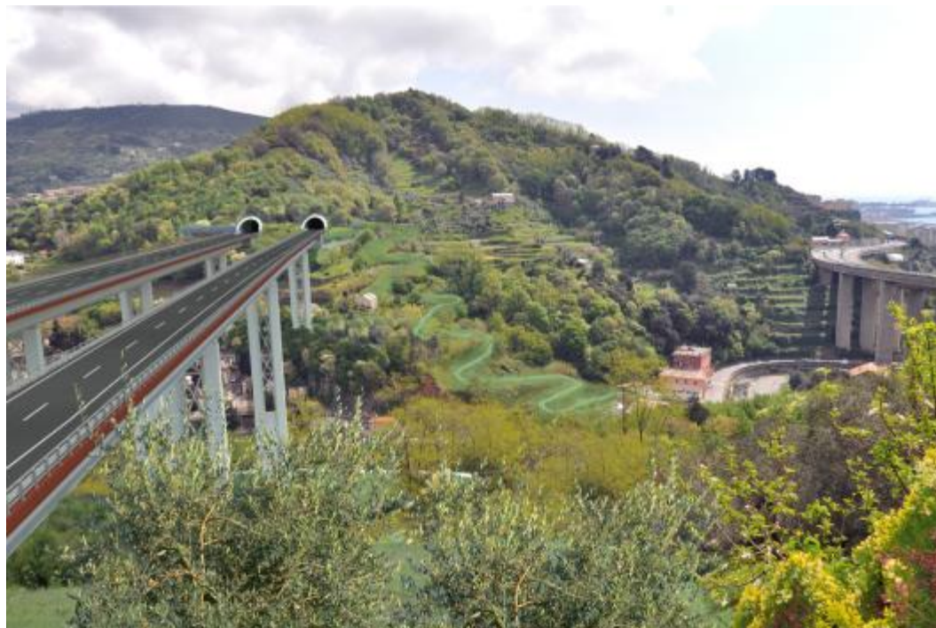
Figura 9 – Viadotti Leiro – Fotoinserimento – Crescita della vegetazione, Variante colorazione opere: tralicciatura pile e impalcato in "greige"
