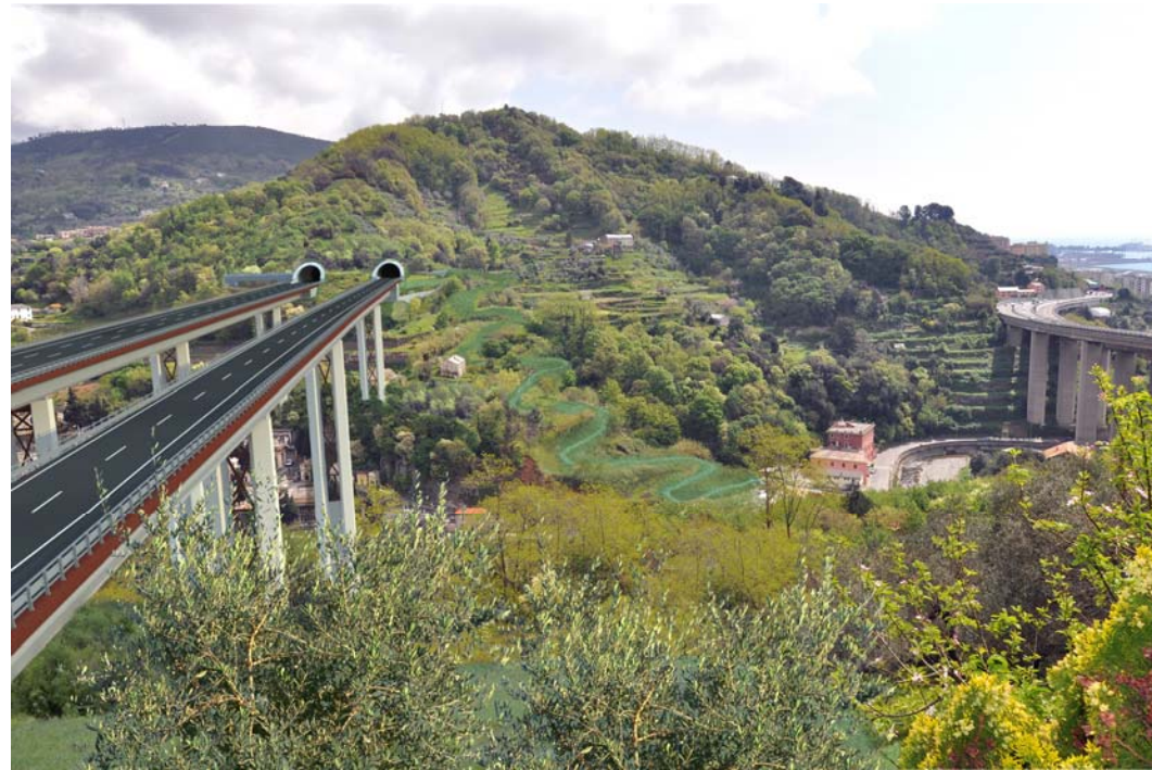
Figura 5 – Viadotti Leiro – Fotoinserimento – Crescita della vegetazione
