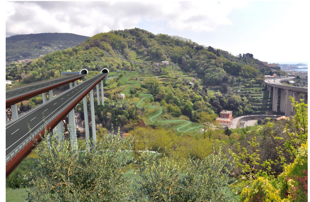
Figura 14 – Viadotti Leiro – Fotoinserimento – Crescita della vegetazione, Variante colorazione opere: setto tra fusti pile in marrone grigiastro
