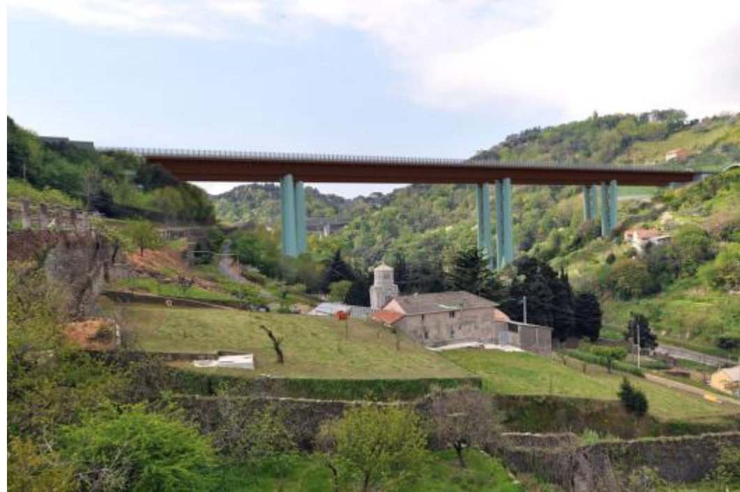
Figura 20 – Viadotti Leiro – Fotoinserimento – Crescita della vegetazione, Variante colorazione opere: pile in grigio-verde
