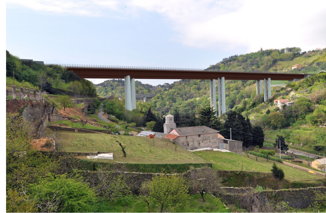
Figura 22 – Viadotti Leiro – Fotoinserimento – Crescita della vegetazione, Variante colorazione opere: setto tra fusti pile in marrone grigiastro
