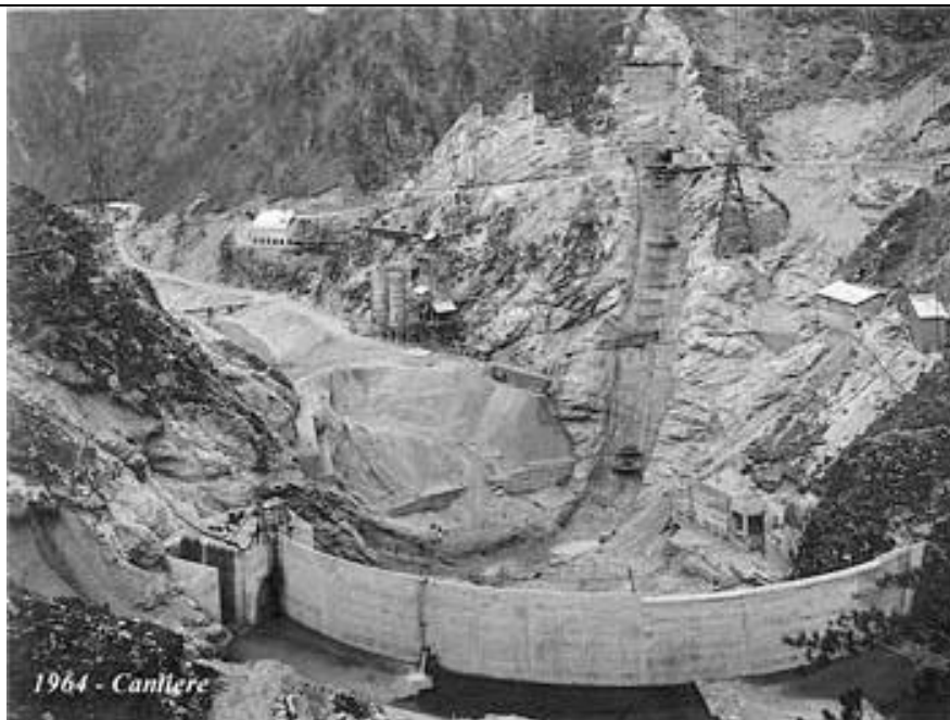
Figura 2.4: fase di costruzione della diga di Ca' Zul
