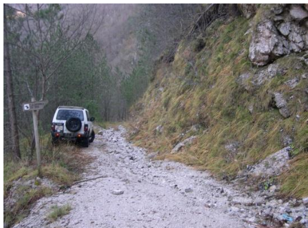
Inizio sentiero 393A che dovrà essere oggetto di adeguamento per consentire il passaggio dei mezzi di cantiere dalla seconda area di cantiere (25x10 m)
