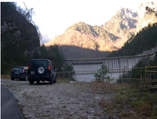
Area di cantiere più prossima alla Diga (20x5 m)
