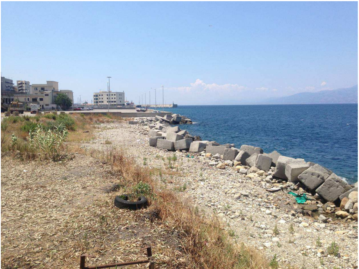
Figura 38 – Panoramiche dell'area costiera interessata d'intervento in cui si può notare l'eccessivo stato di degrado
