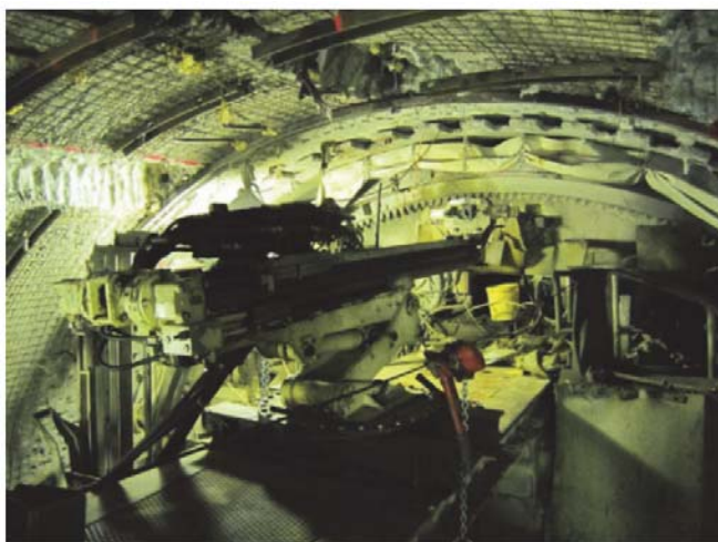
Figura 6.8 – Esempio di posizionamento di una perforatrice nella parte superiore del fronte di scavo di una TBM.
