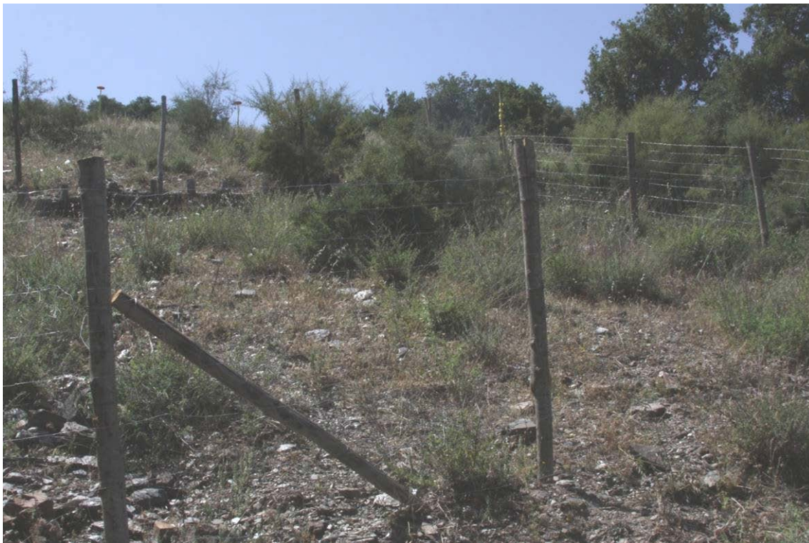
Foto 3.8 - Area test 02 "Passalacqua": panoramica di VEG02.
