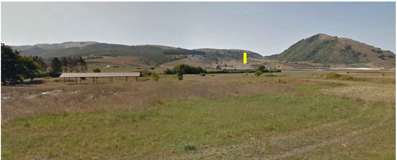
Foto 3 - Traliccio 52 al margine Piana di Colfiorito, dietro la Quadrilatero (nella foto cantieri aperti)
