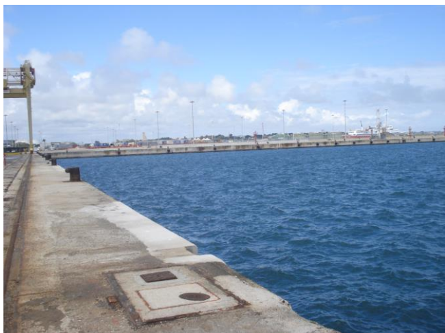
Pozzetto di arrivo del terminale
