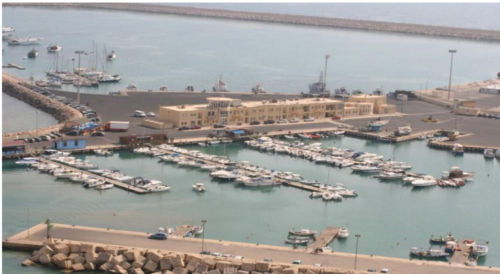
Fig. 10 – Edificio sede della Capitaneria di Porto
