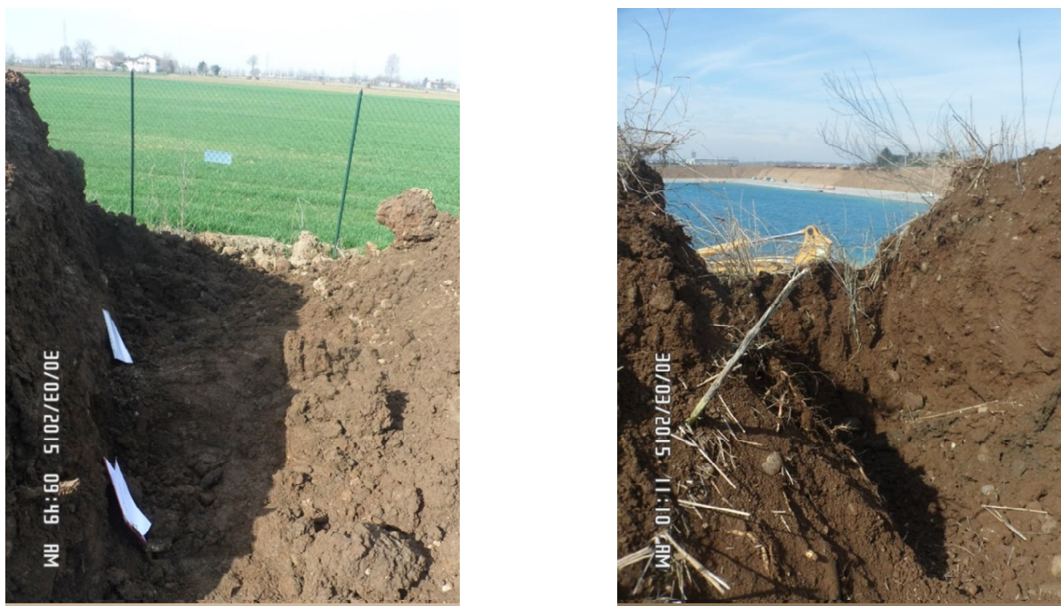
Figura 2-2: Sbancamento delle dune.
