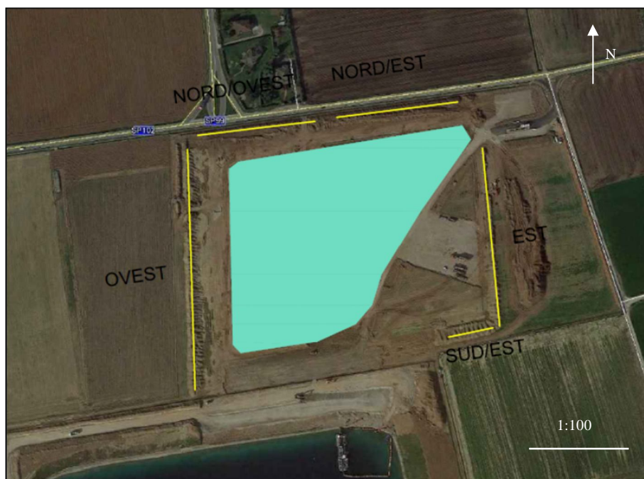
Figura 2-1: Localizzazione dell'area di cantiere.
