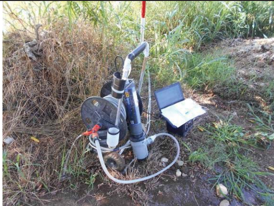
Punto AV-CO-SO1-BG3.4. Spurgo
