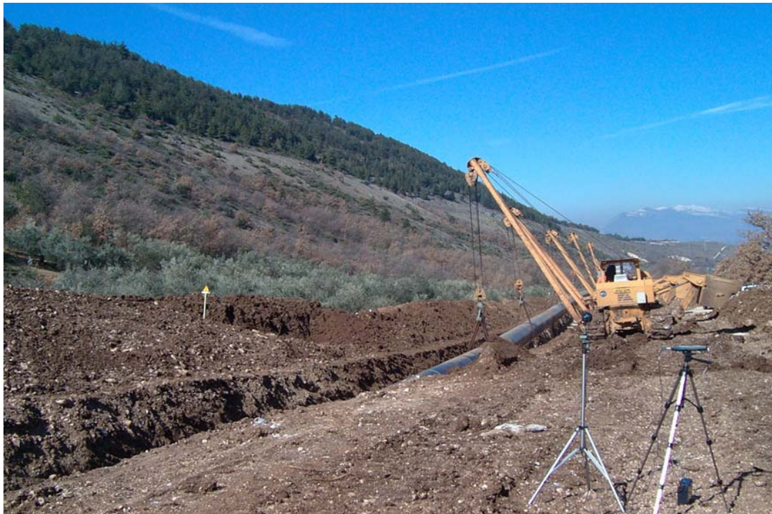
Fig. 5.2/A: Rilievi acustici durante l'operazione di posa di una condotta
