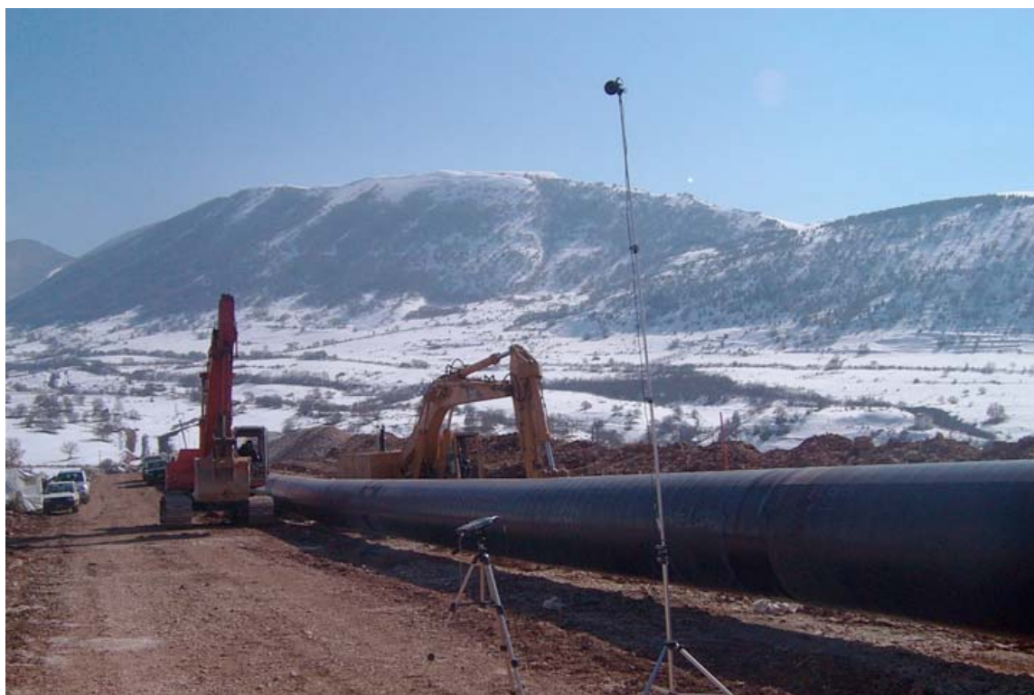
Fig. 6.3/B: Rilievi acustici durante l'operazione di scavo della trincea ospitante la condotta
