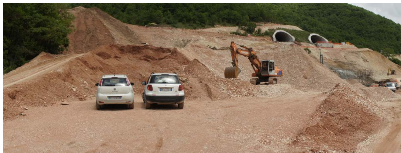
Figura 6.b - Immagine dell'area in fase di cantiere
