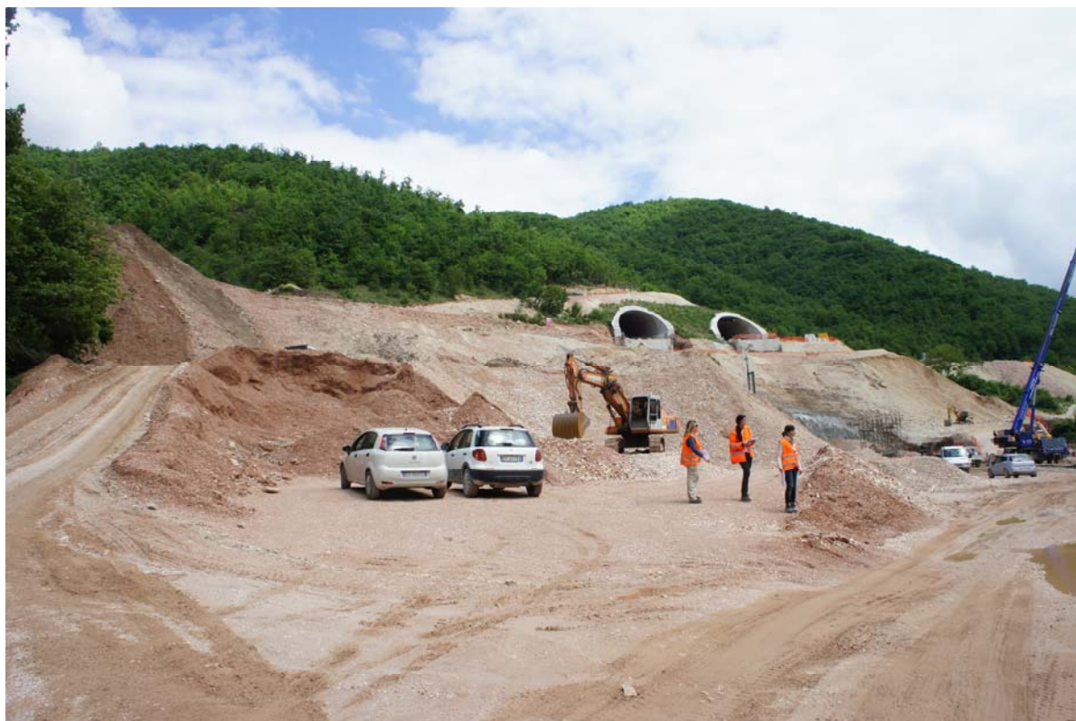
Figura 6.a - Immagine dell'area in fase di cantiere
