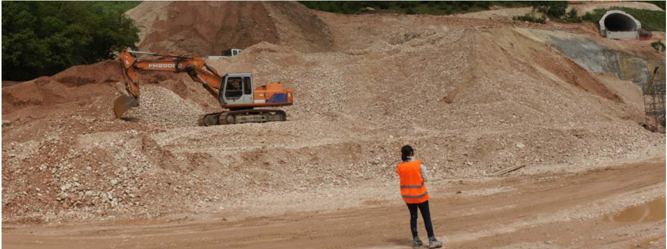
Figura 6.c - Immagine dell'area in fase di cantiere
