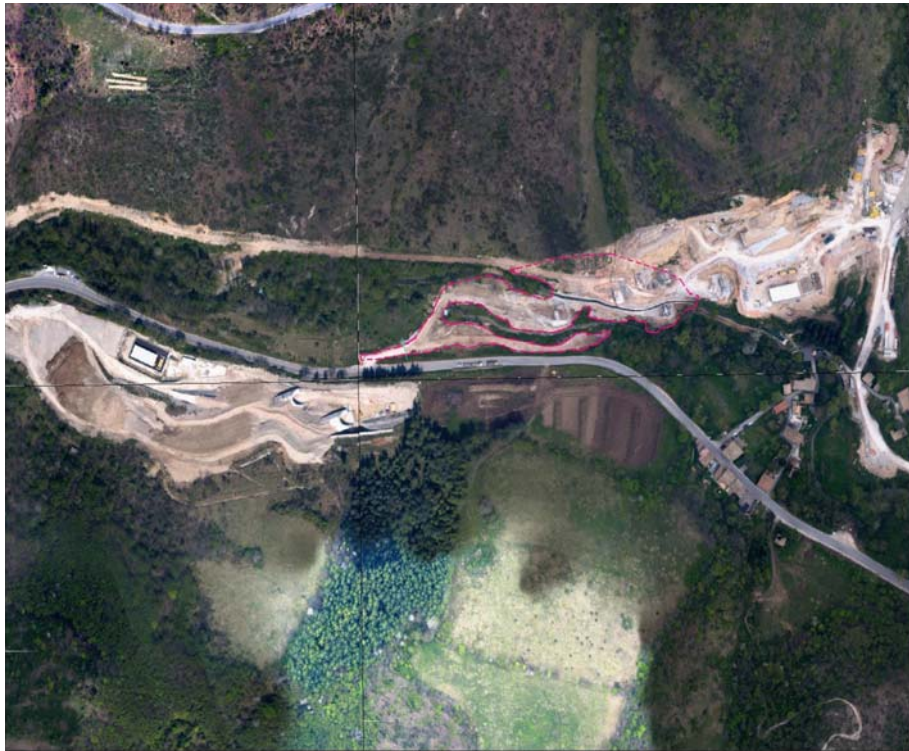
Figura 2 - Ortofoto d'inquadramento dell'area "ST12" stato attuale.
