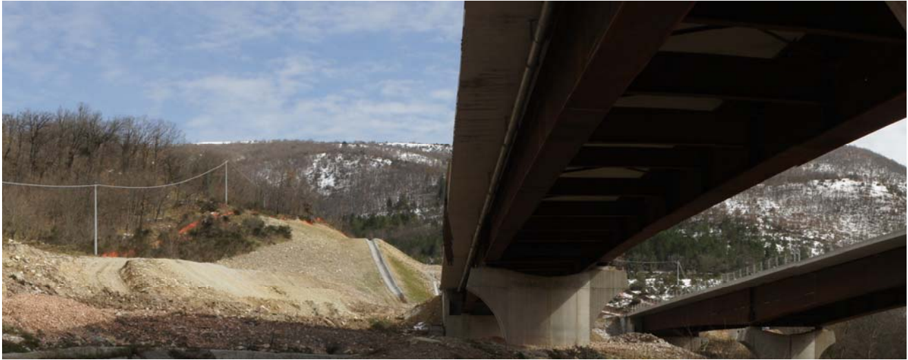
Figura 6 - Immagine dell'area in fase di cantiere
