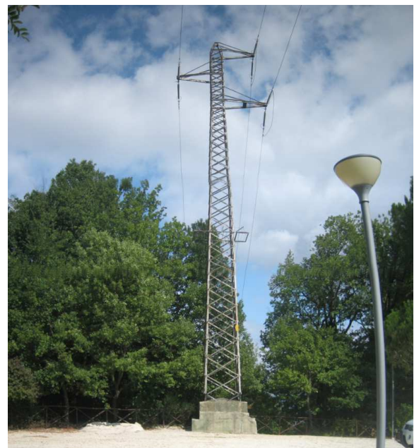
Sostegni esistenti del 1925
