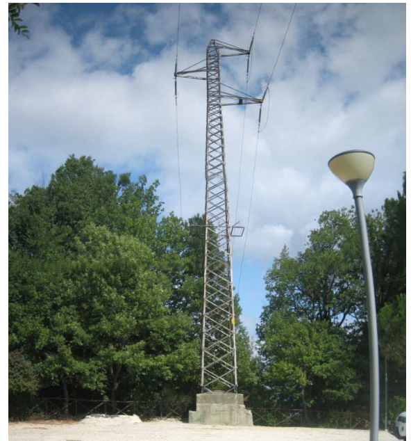
Sostegni esistenti del 1925
