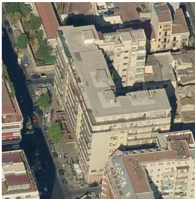
Figura 52 – Recettore 4, Chiesa Cristiana Evangelica Internazionale; via dei Cantieri (fonte: http://it.bing.com/maps/ )
