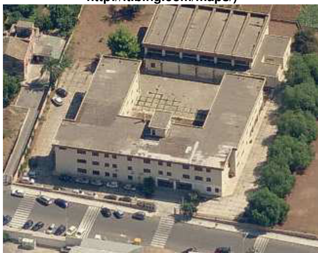
Figura 59 – Recettore 11, istituto comprensivo Abba Alighieri; via R. Marturano (fonte: http://it.bing.com/maps/ )
