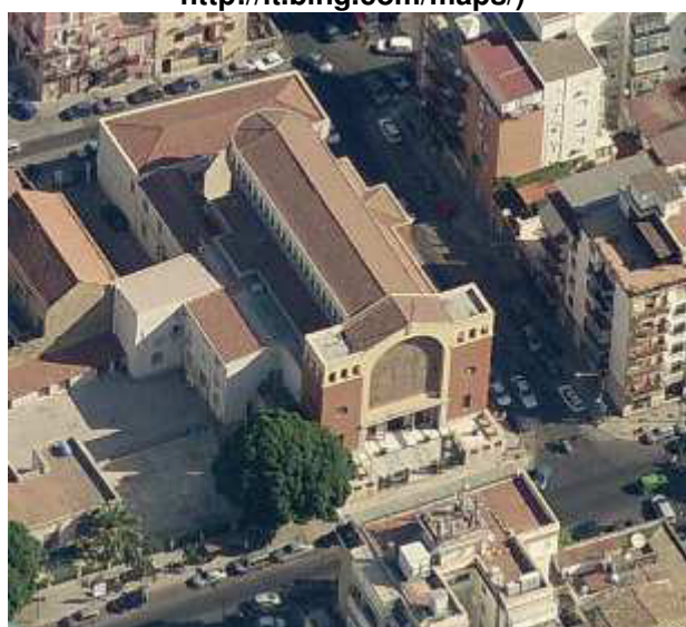
Figura 51 – Recettore 3, Parrocchia Nostra Signora della Consolazione in Via dei Cantieri (fonte: http://it.bing.com/maps/ )
