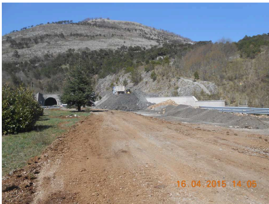
Figura 1: Ritombamento costone imbocco sud galleria Serra Rotonda – area critica 2
