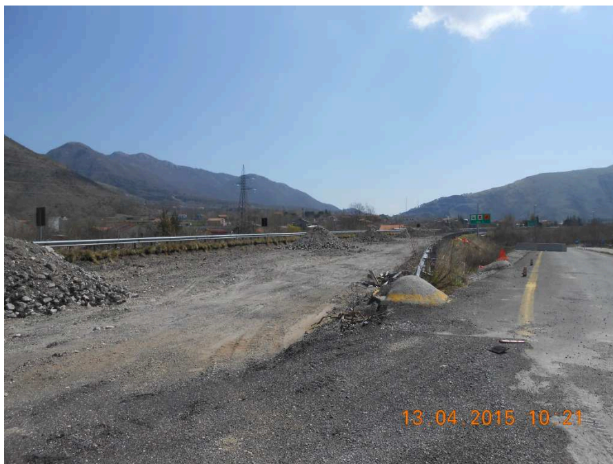
Figura 11: Dismissione rampa svincolo Lauria Sud
