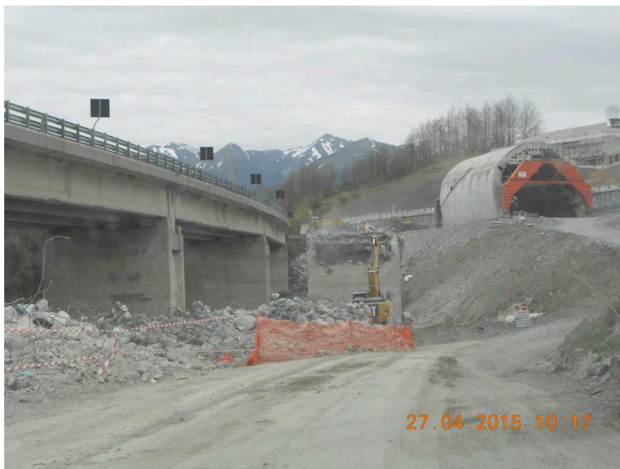
Figura 7: Demolizione Viadotto Cavallo carr. Sud – area critica 1
