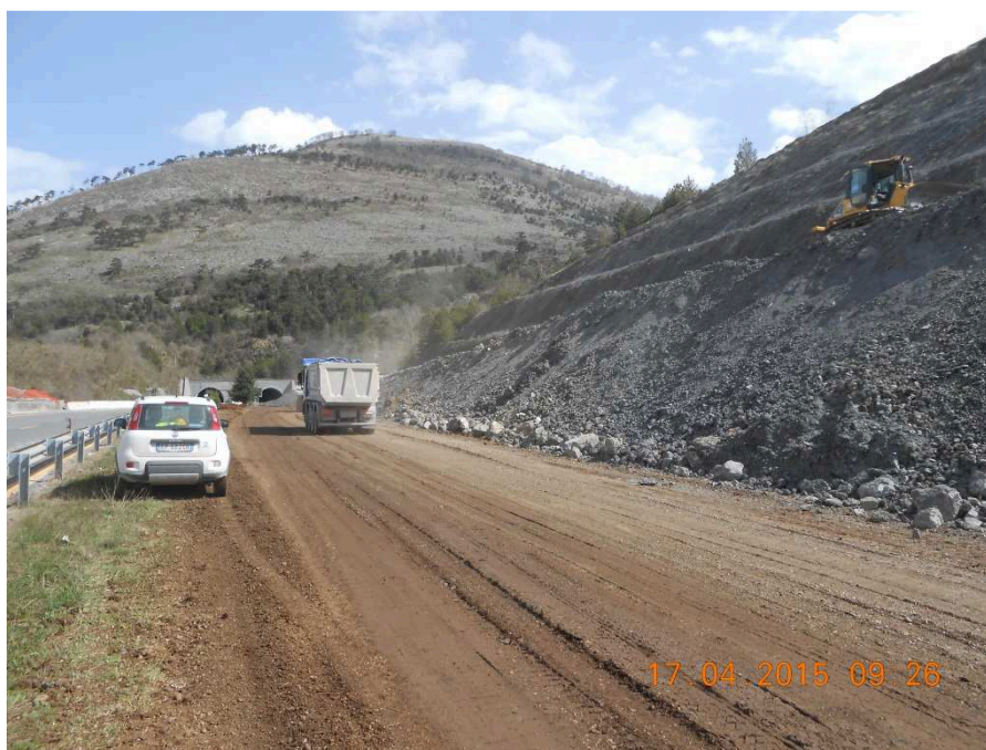
Figura 2: Ritombamento costone imbocco sud galleria Serra Rotonda – area critica 2
