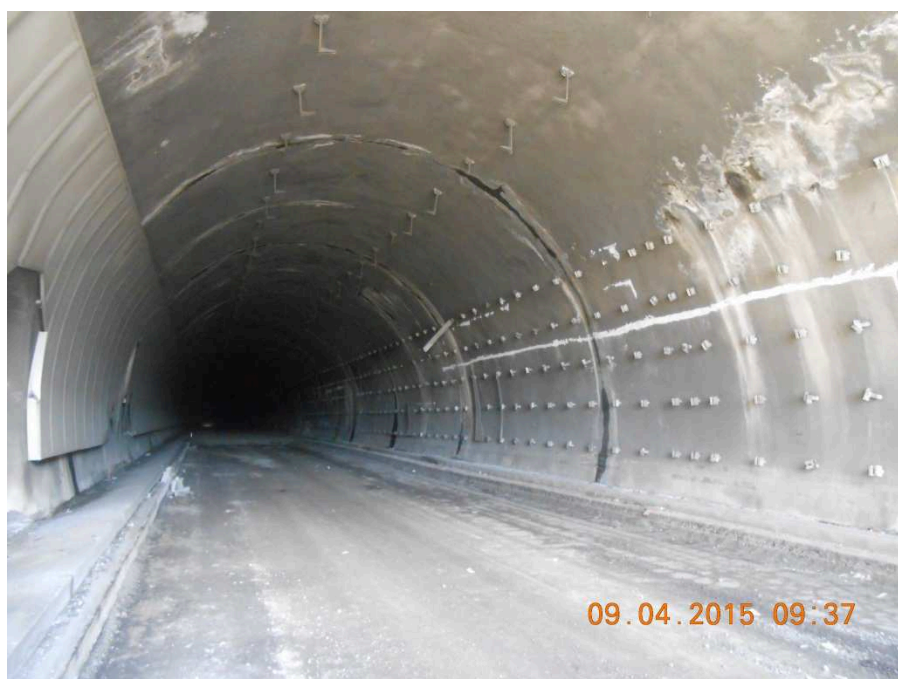
Figura 8: Rimozione pannelli vecchia galleria Serra Rotonda – area critica 1
