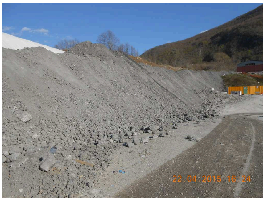
Figura 6: Ritombamento Galleria Serra Rotonda (imb. nord) nuova sede autostradale
