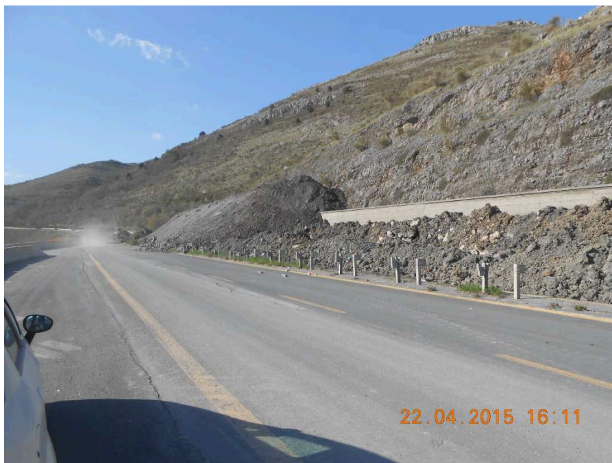
Figura 9: Ritombamento costone tra Viadotto Pianicelli I e Viadotto Caffaro – area critica 2
