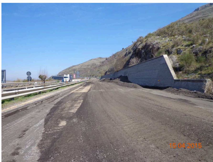
Figura 10: Fresatura tra Viadotto Pianicelli 2 e Viadotto Caffaro – area critica 5
