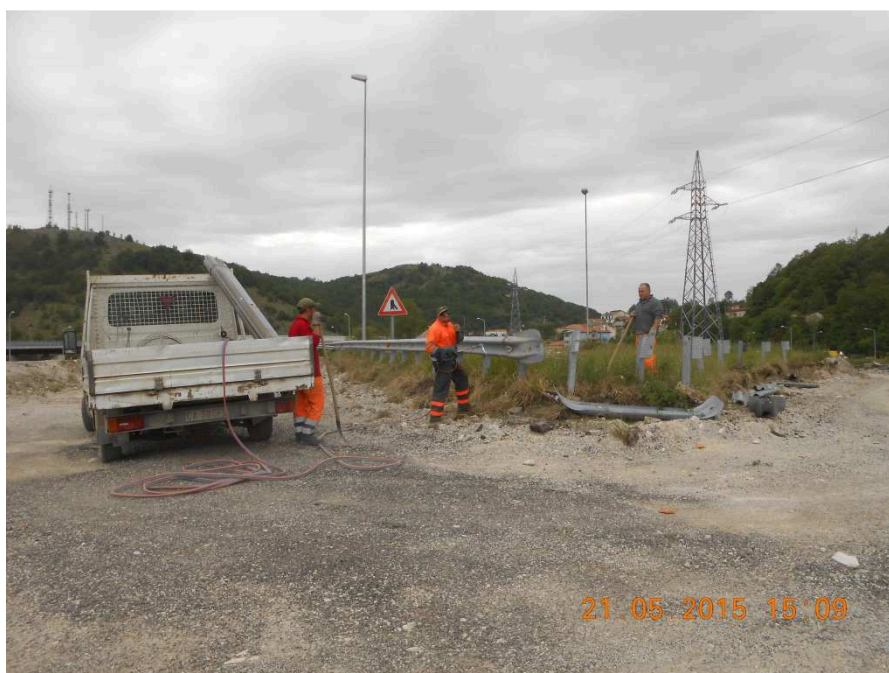
Figura 12: Rimozione barriere vecchio svincolo Lauria Sud
