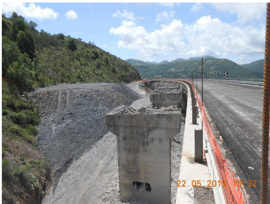
Figura 9: Demolizione Viadotto Pianicelli 1 carr. nord – area critica 3
