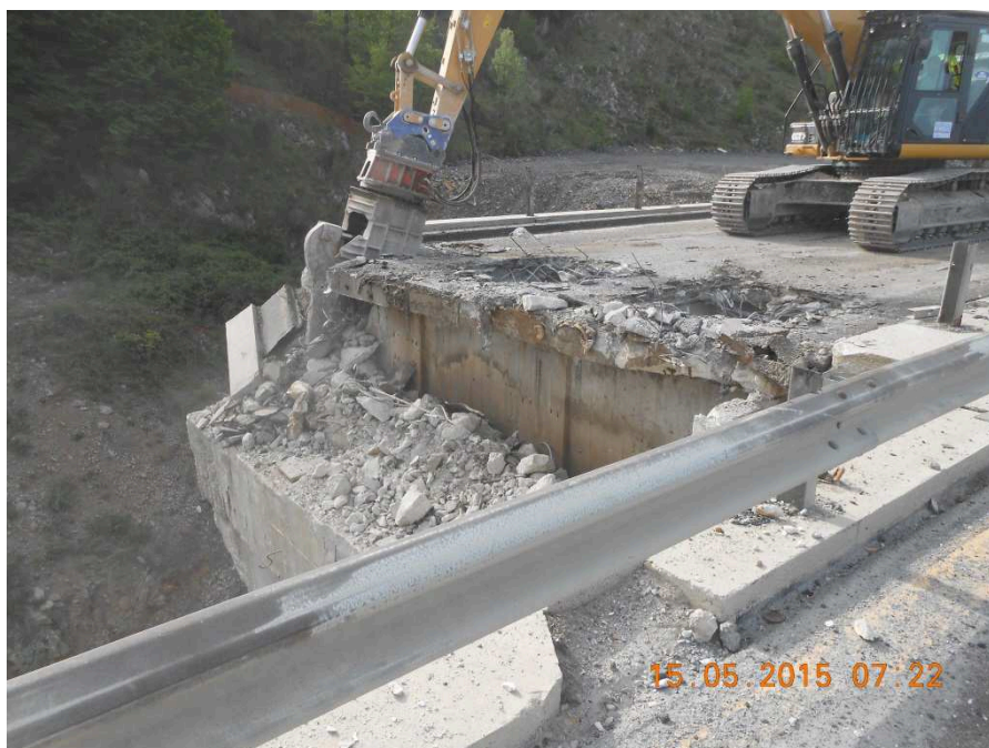
Figura 8: Demolizione Viadotto Pianicelli 1 carr. nord – area critica 3
