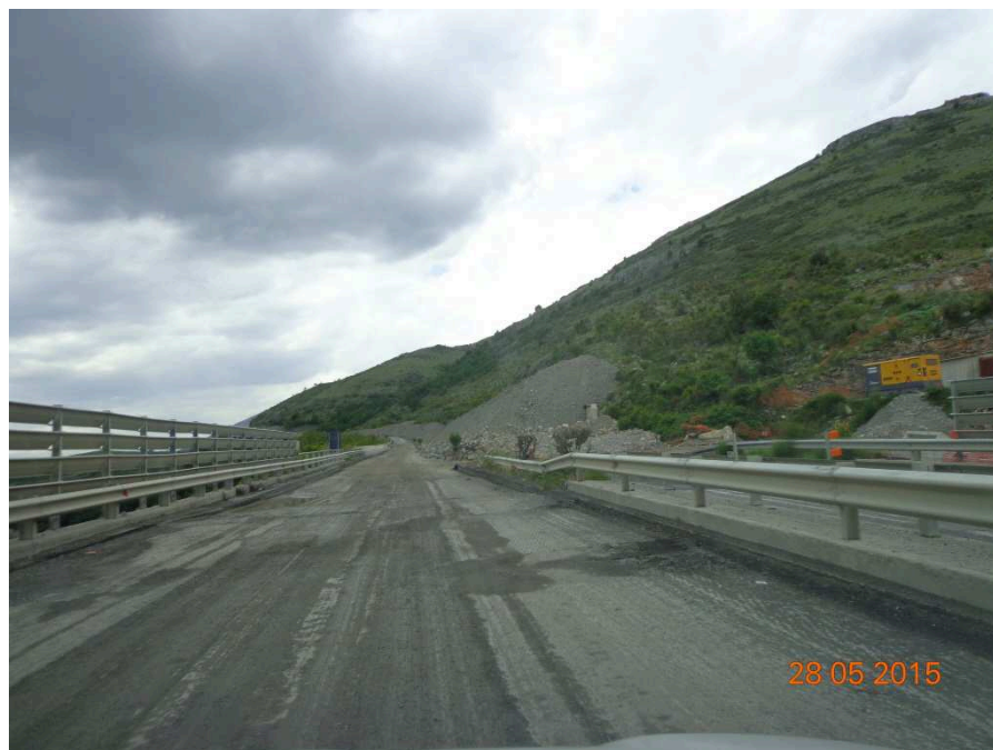
Figura 11: Ritombamento costone tra Viadotto Pianicelli 2 e Viadotto Caffaro – area critica 5
