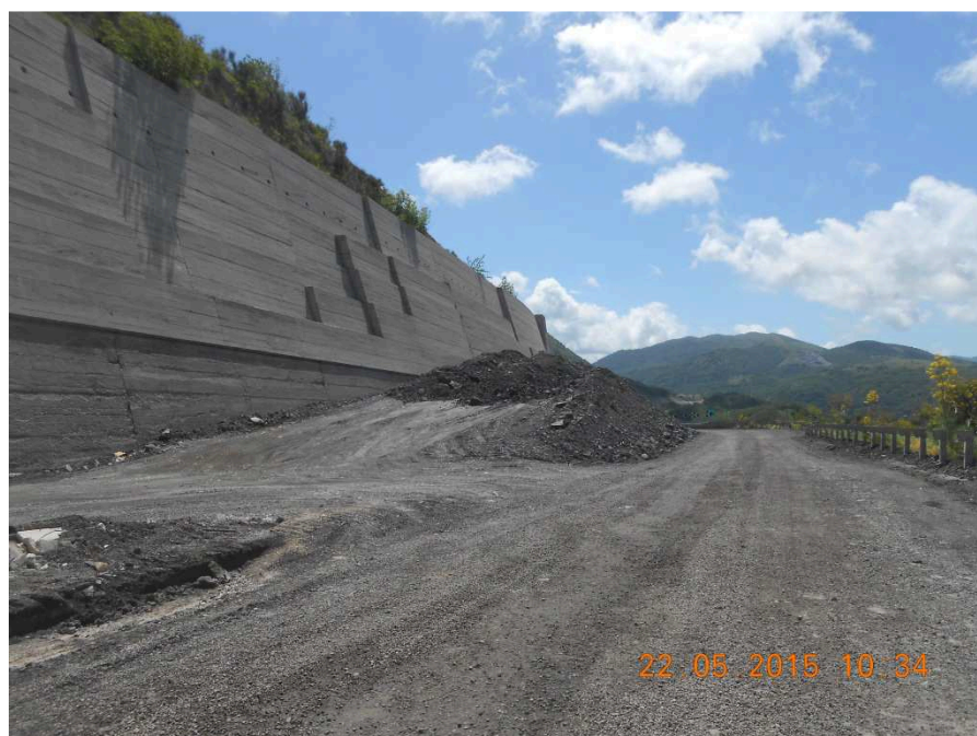
Figura 10: Riprofilatura tra viadotto Pianicelli 1 e Pianicelli 2 – Area critica 4
