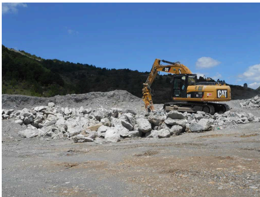
Figura 3: Sito 2 – Riduzione primaria cls per mezzo di pinza
