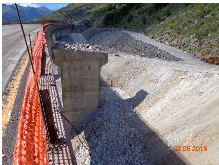
Figura 6: Viadotto Pianicelli 1 carr. nord – area critica 3
