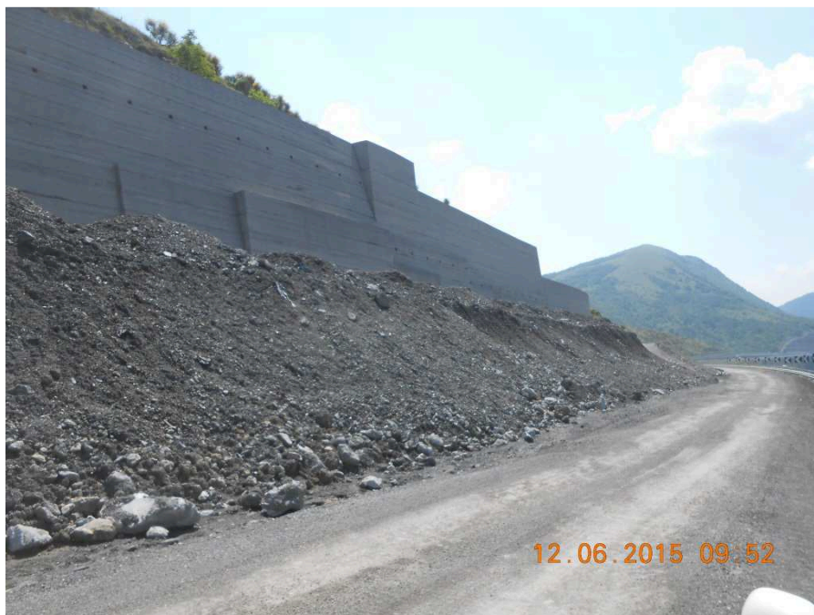
Figura 7: Riprofilatura tra viadotto Pianicelli 1 e Pianicelli 2 – Area critica 4
