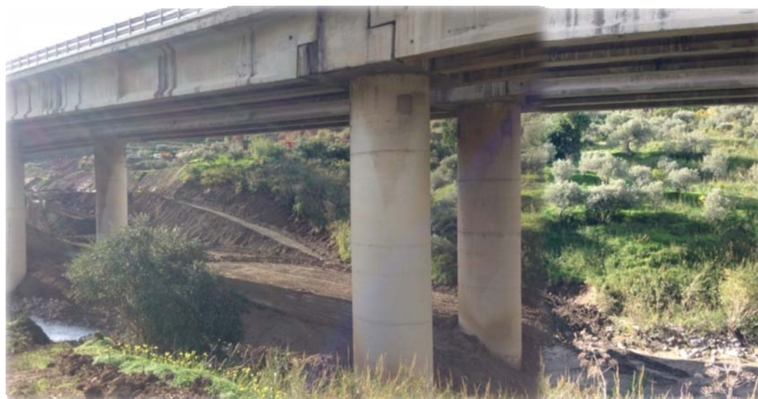
Foto 5: area di cantiere relativa alla fase di demolizione del Viadotto Imera
