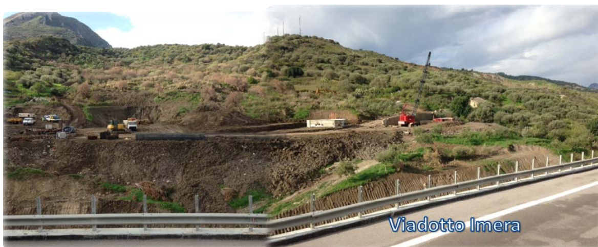
Foto 4: area di cantiere relativa alla fase di demolizione del Viadotto Imera
