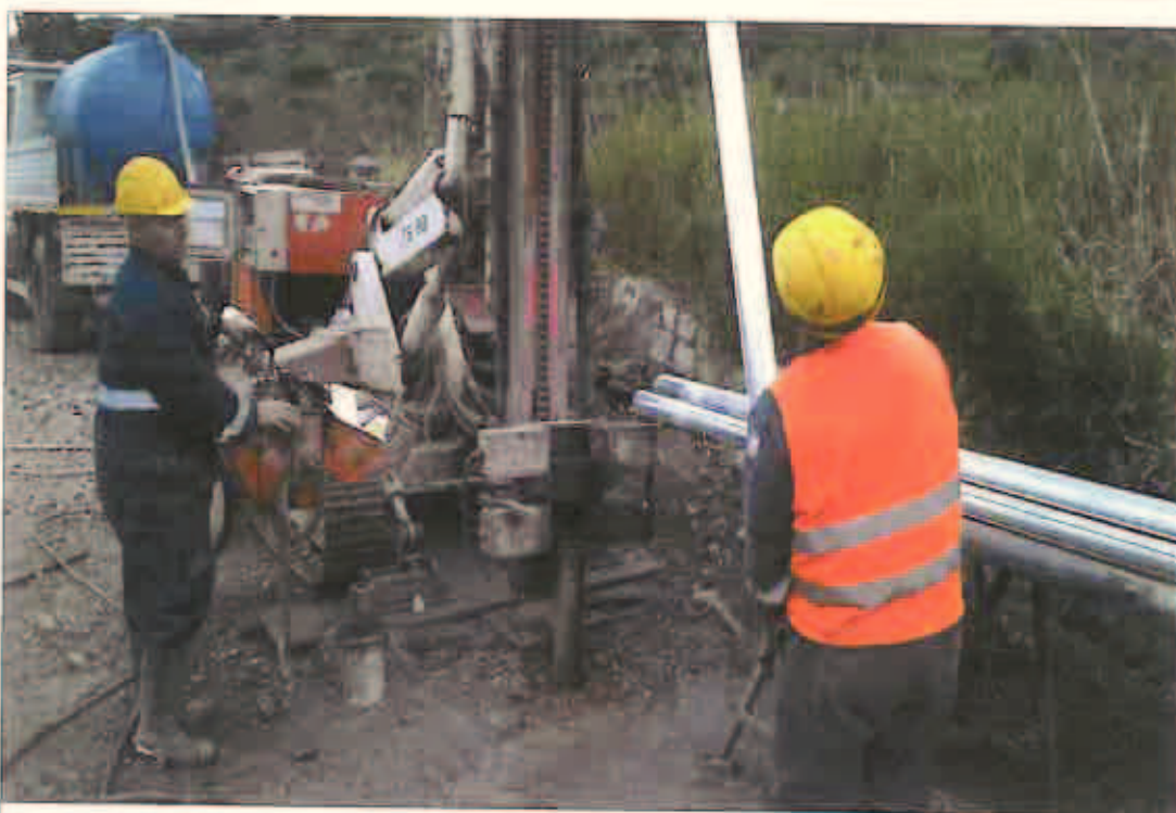
S3-Installazione Inclinometro
