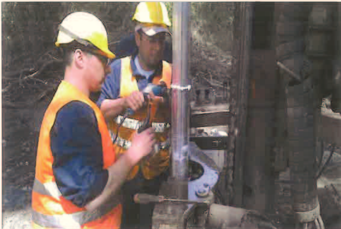
S1-Installazione Inclinometro
