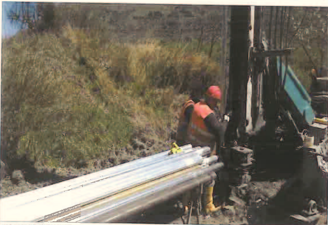
S4-Installazione Inclinometro
