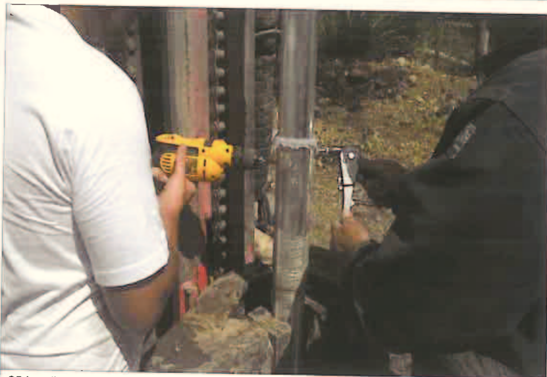
S5-Installazione Inclinometro
