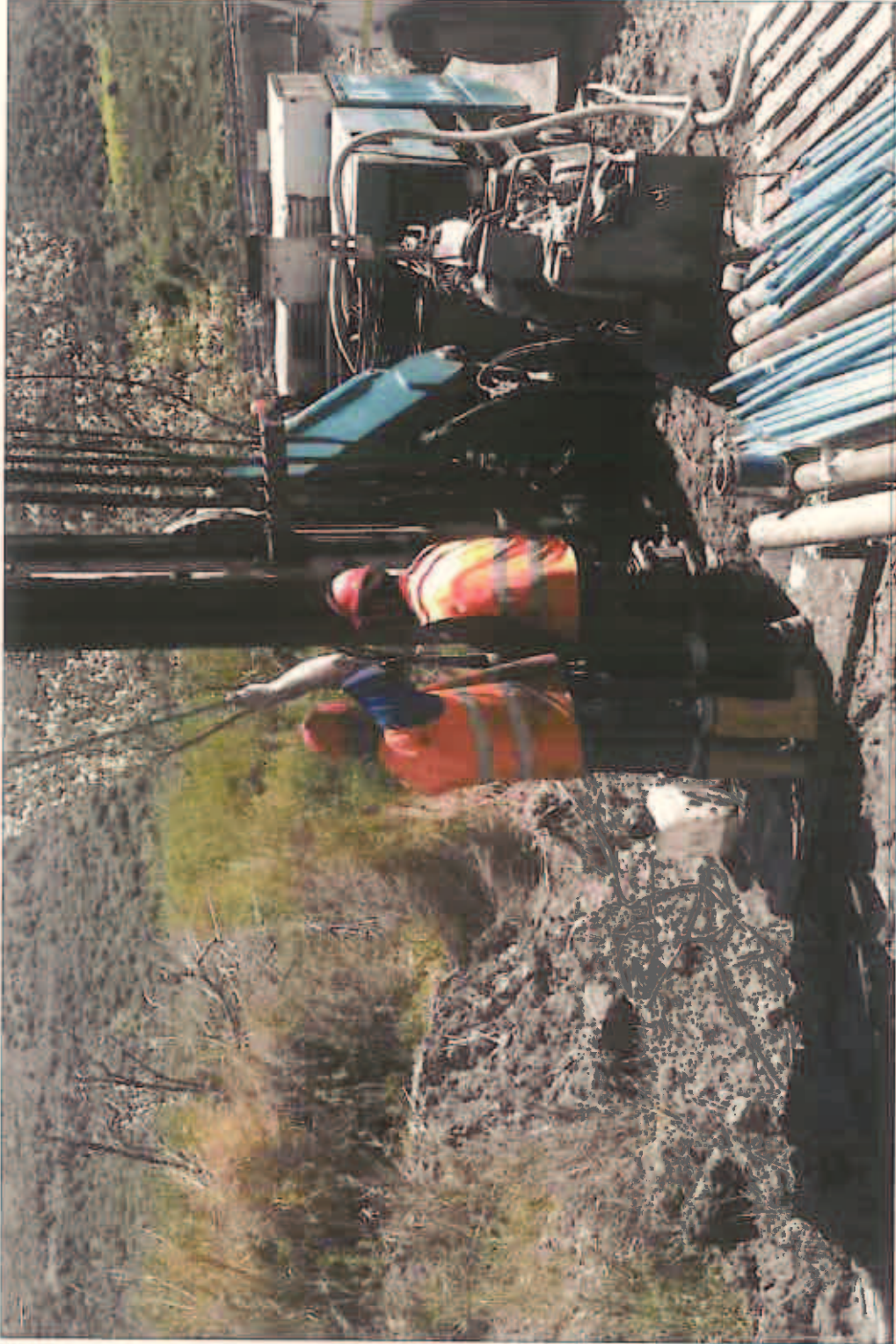
S4-Installazione Piezometro
