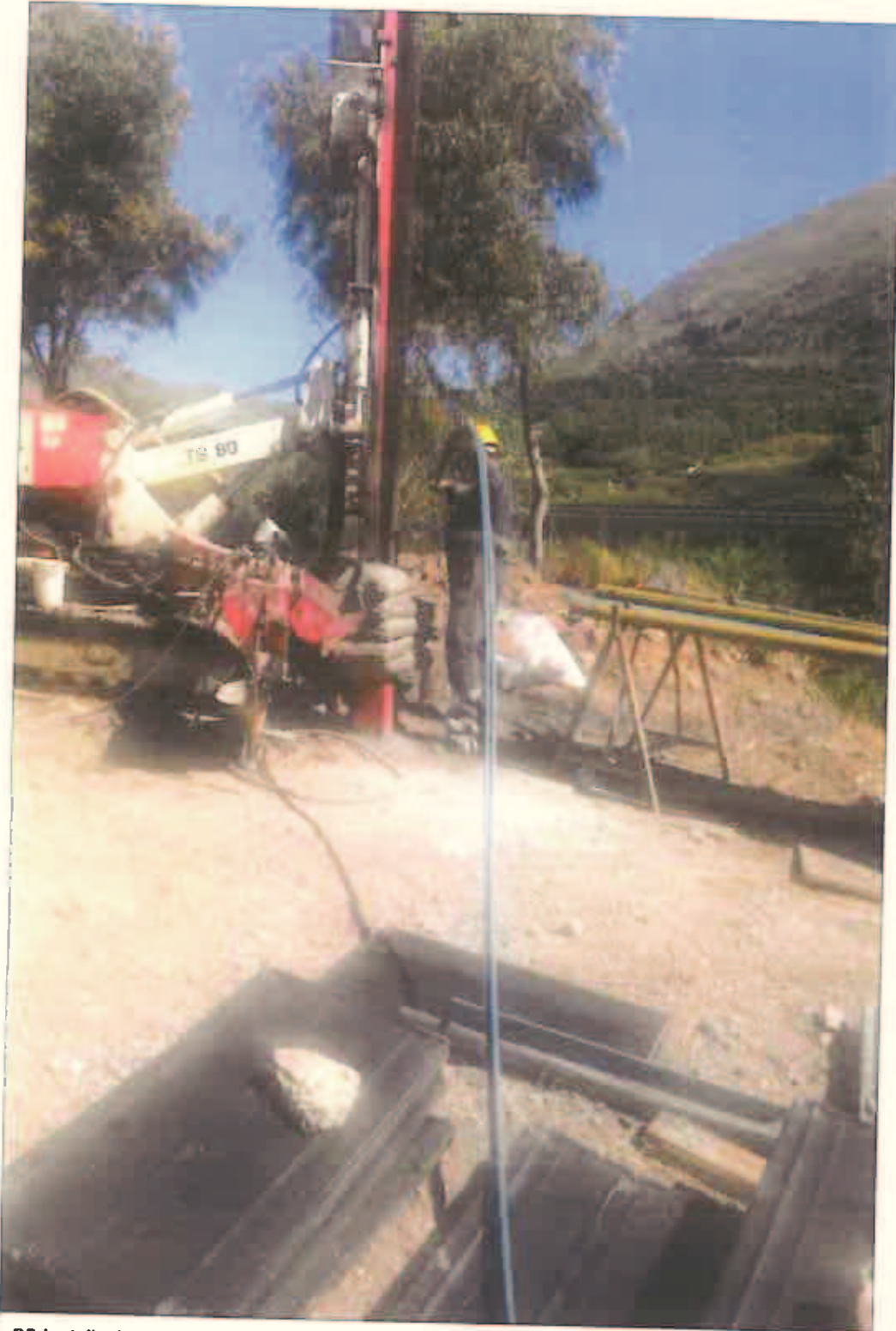
S5-Installazione Piezometro
