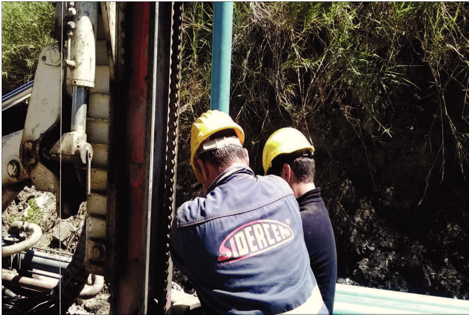
S8-Installazione tubi per Down-Hole
