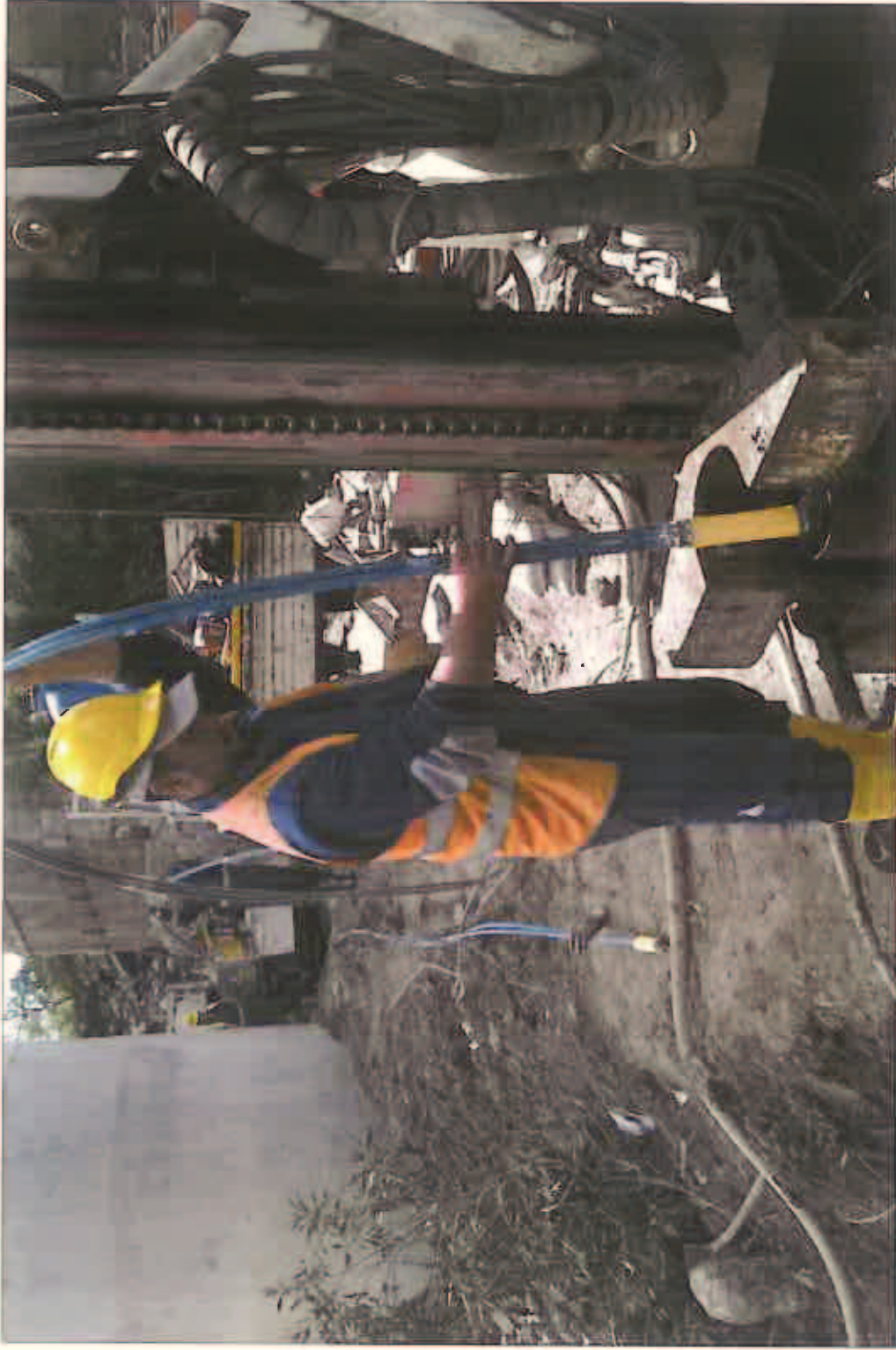
S1PZ-Installazione Piezometro
