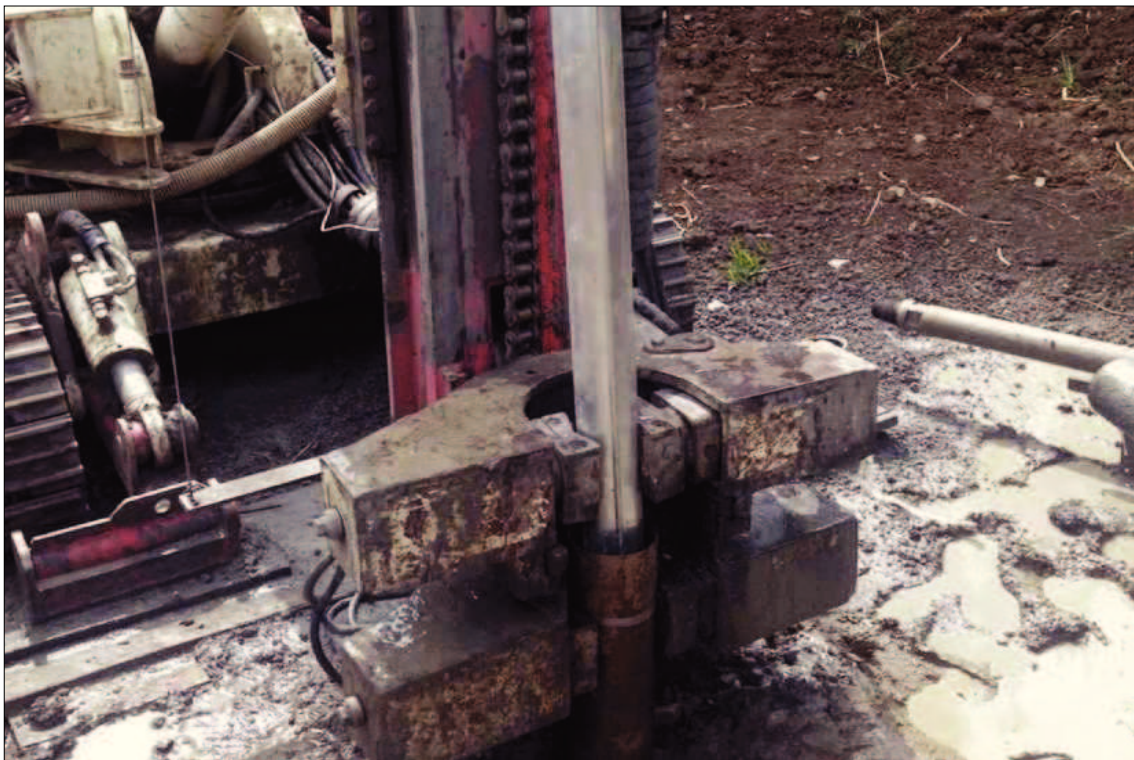
S6-Installazione inclinometro
