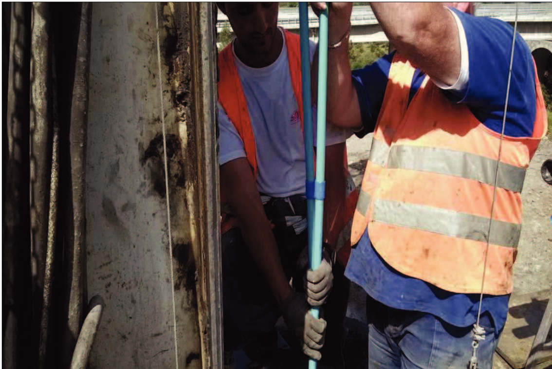
S7-Installazione Piezometro
