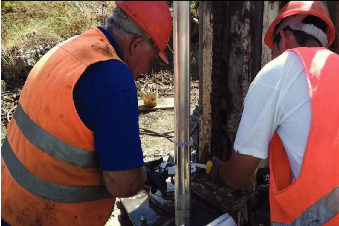
S7-Installazione Inclinometro
