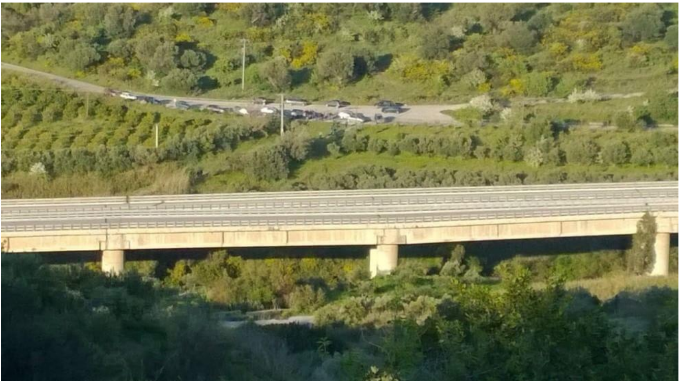
Figura 3 – Foto aerea del viadotto in corrispondenza del cedimento (vista da sud).
