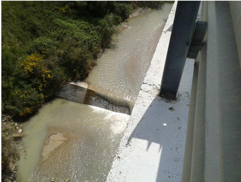
**Fig. 1 Briglia in c.a. esistente in corrispondenza della pila 18 del Viadotto Imera**
