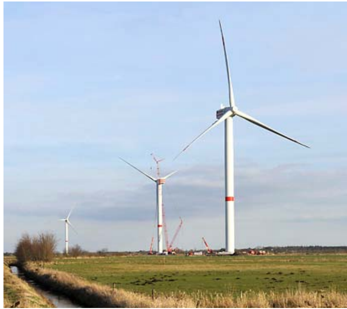
Figura 2-3 Westre wind farm (confine tra Germania e Danimarca – marzo 2009) - 3 aerogeneratori REpower 6M in fase di test
