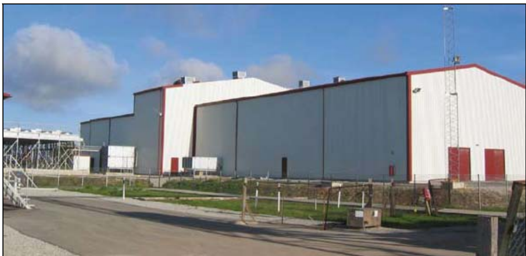
Figura 2-21 ESP ABB HVDC Light da 350 MVA installata ad Harku , Estonia
