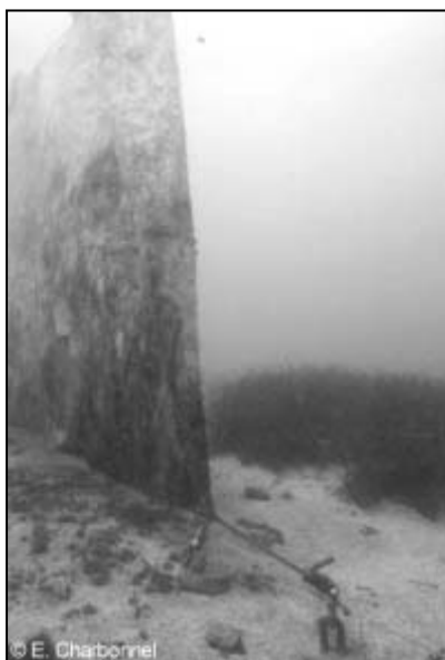
Figura 3-5 Uno schermo in geotessile (a sinistra) che protegge una prateria di Posidonia oceanica (a destra) in un lavoro sottomarino in Francia. (foto E. Charbonnel)
