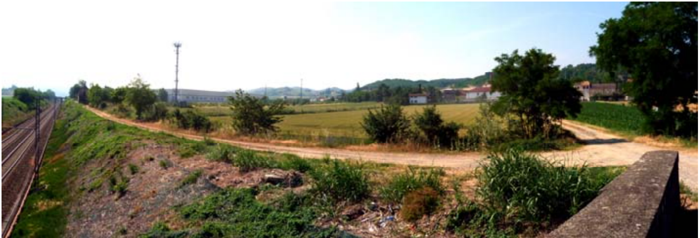
Figura 5–18 Panoramica sull'area di cantiere vista dal cavalcaferrovia esistente
