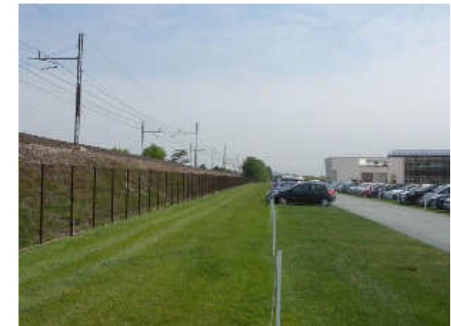
4 - Rilevato ferroviario contermine
