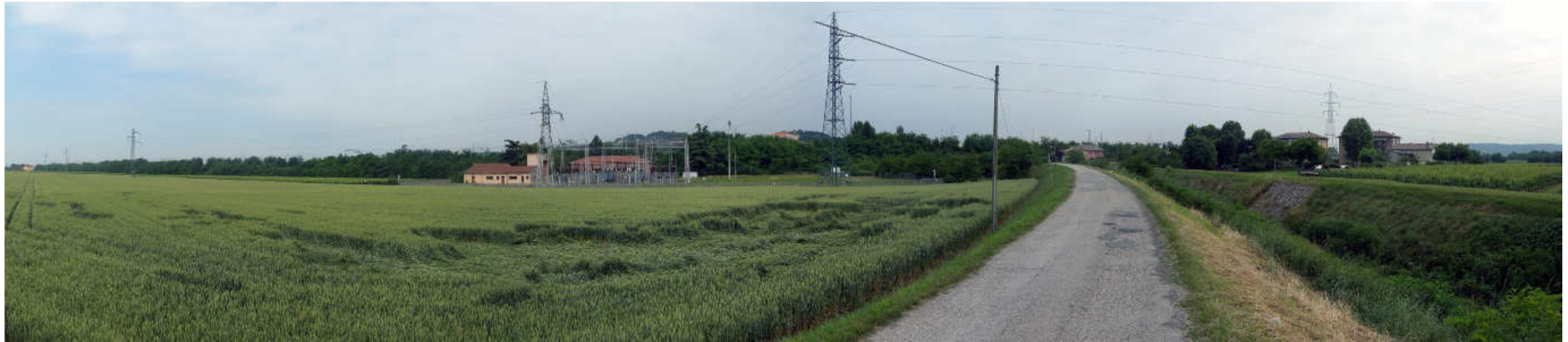
1 - Panoramica verso Nord. In evidenza la sottostazione esistente
