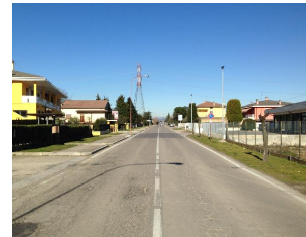
Figura 45 - Strada Provinciale 38 (ripresa verso Ovest)
