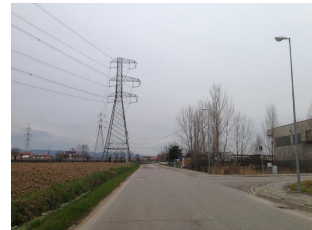
Figura 50 - Percorrenza strada della Selva, zona industriale (ripresa verso Nord)
