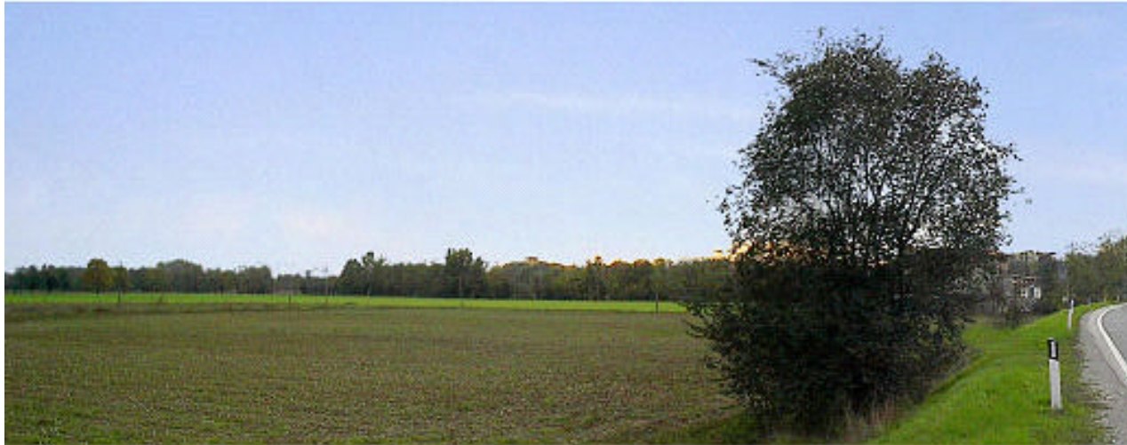
Fig. 4.6/3 Variante agli abitati di Sola e Isso - Tratto iniziale della variante – rotatoria di allacciamento alla SS 11
