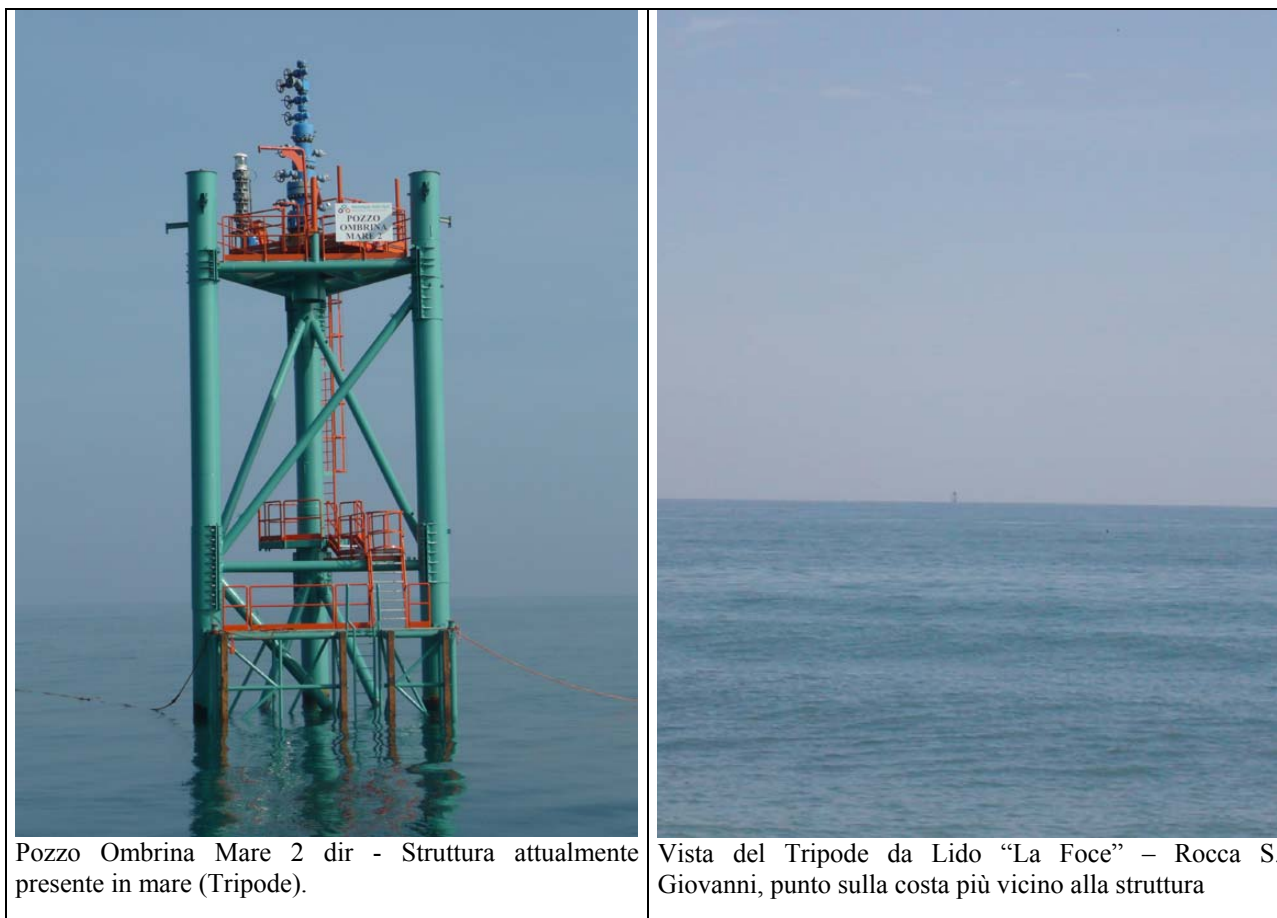
Figura 4.2.2.a – Struttura a traliccio esistente – Testa pozzo Ombrina Mare 2 Dir.
