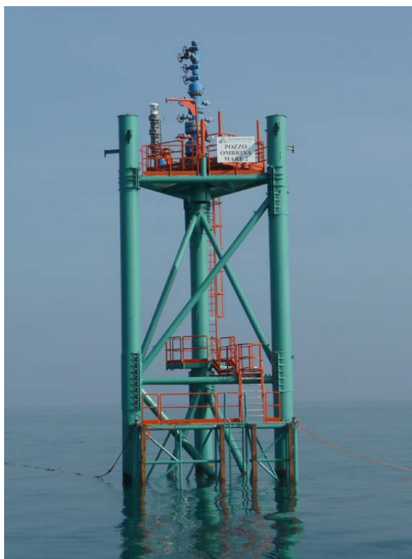
Figura 2.2.a – Struttura a traliccio con testa pozzo Ombrina Mare 2 Dir
