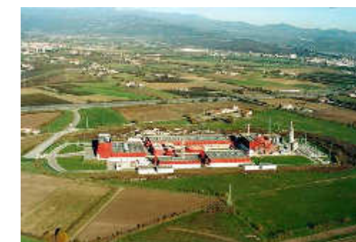
6 - Vista aerea termovalorizzatore Cà del Bue
