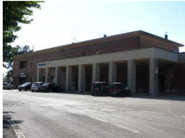
Stazione Lonigo vista da Sud-
