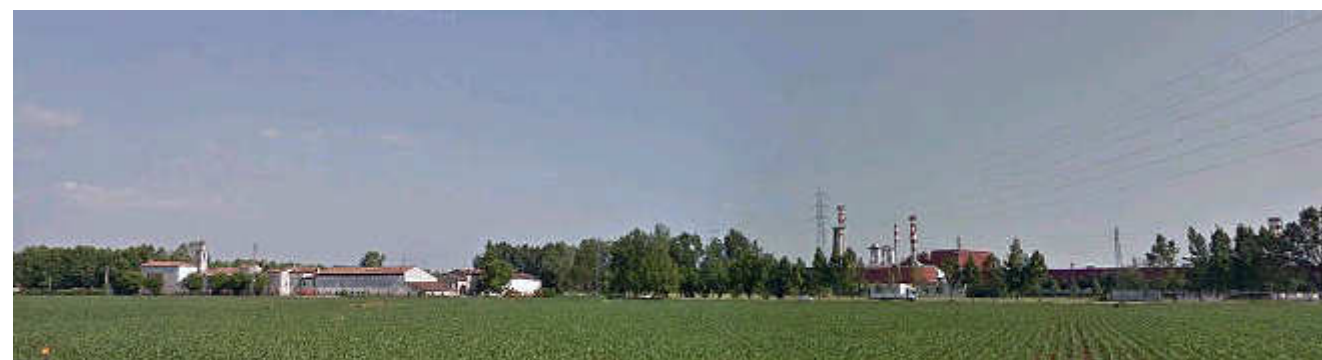
5 - A sinistra Cà del Bue, a destra il termovalorizzatore
