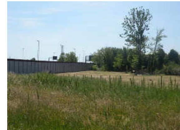
3 - L'area a Sud del raccordo autostradale in corrispondenza del tracciato AV/AC
