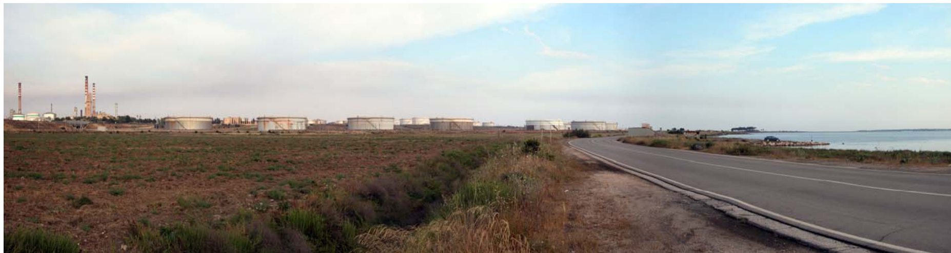
Figura 5.4-1: Strada di servizio a ovest raffineria, stato attuale
