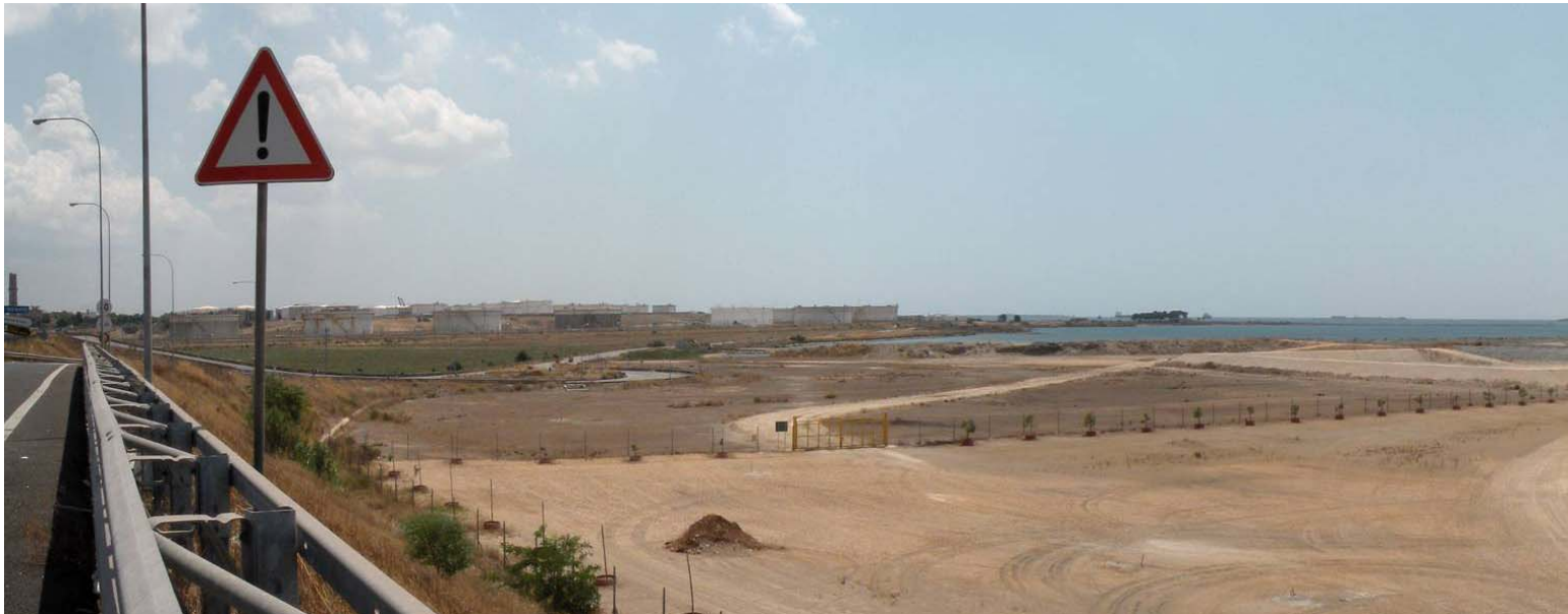
Figura 5.4-7: SS 106, uscita strada di servizio, stato attuale
