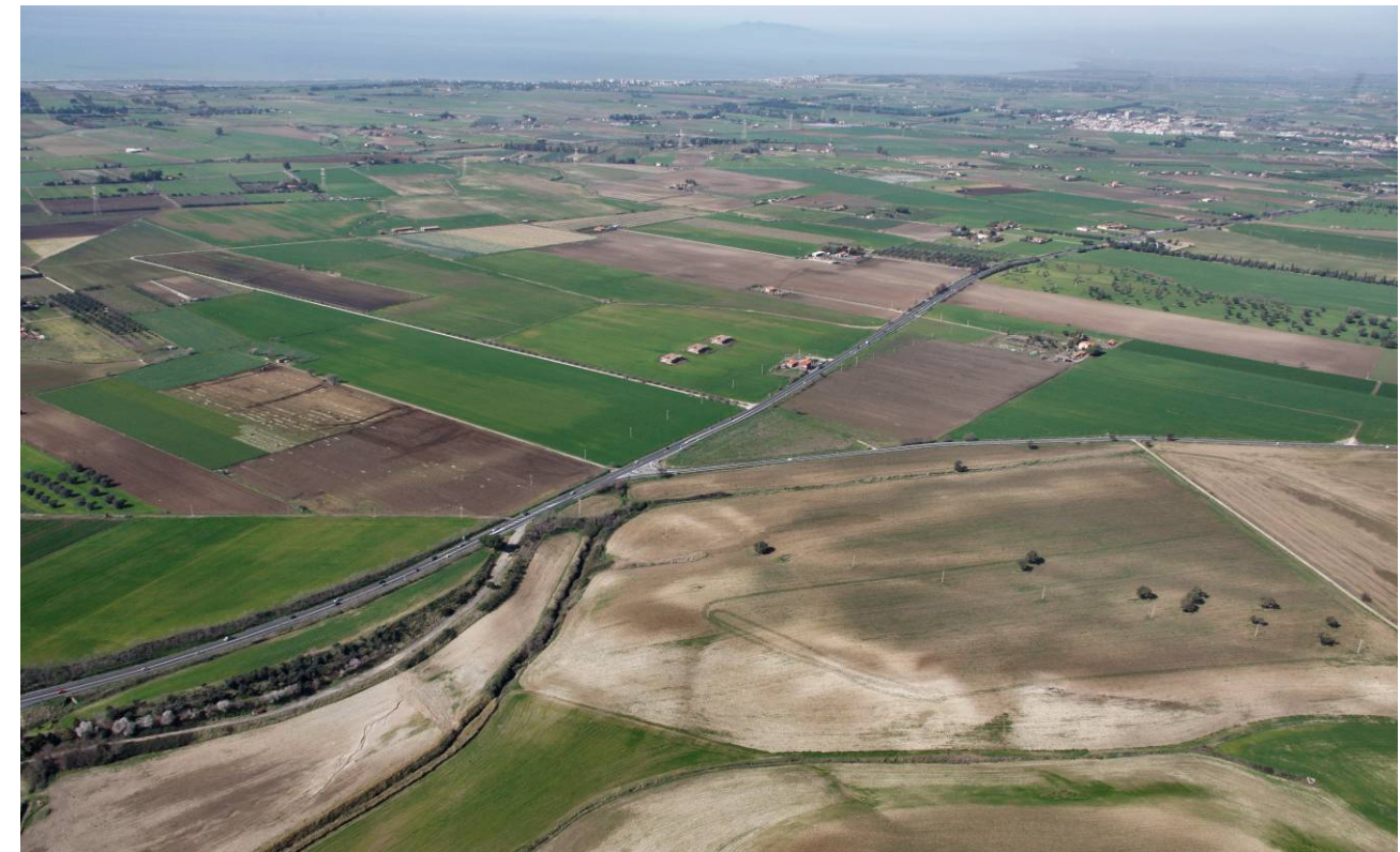
Figura 10 – Lo stato attuale dell'area all'intersezione tra S.S. 1 Aurelia e S.S. 1 Bis.
