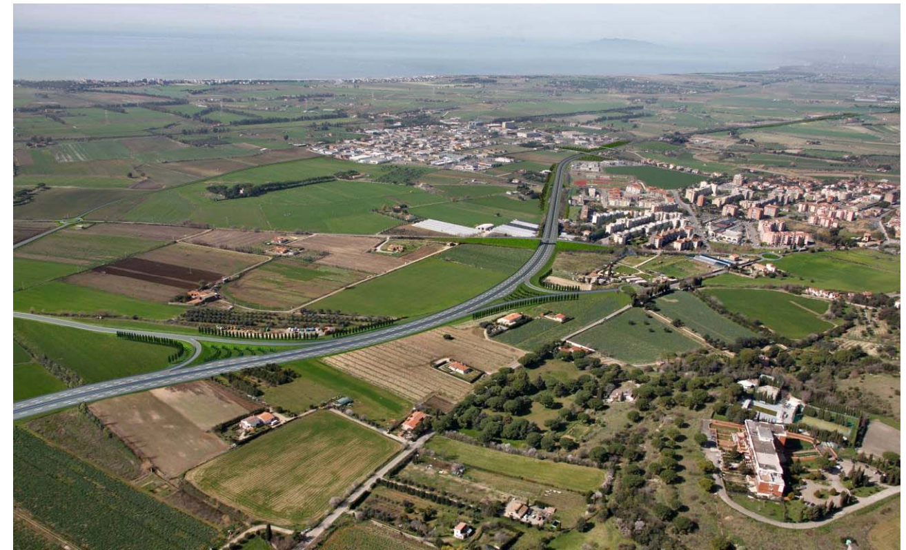
Figura 7 – L'intervento in progetto, che permette di mantenere la visuale privilegiata del centro storico di Tarquinia e lo svincolo di Tarquinia, con i suoi filari di cipressi.
