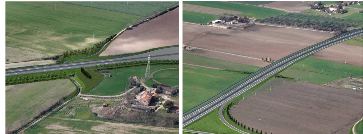
Figura 5 – Due esempi di filari di cipressi che segnano i punti dove la viabilità minore sovrappassa/sottopassa l'autostrada o dove s'innesta in una complanare.
