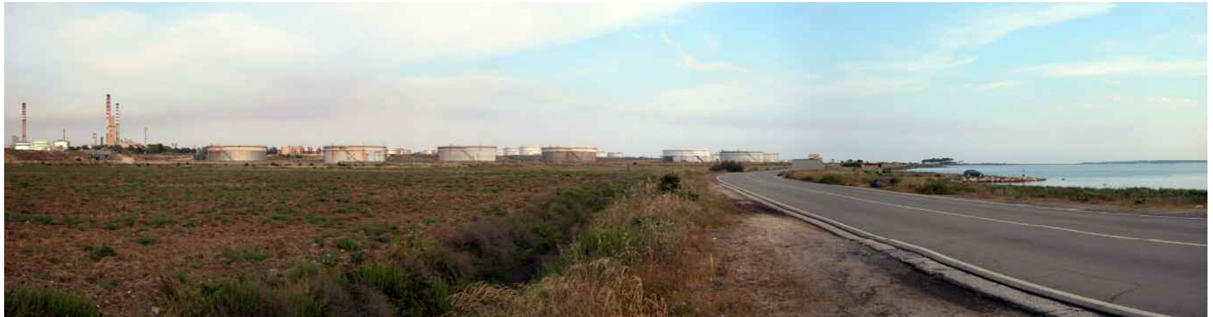
Figura 5.4-1: Strada di servizio a ovest raffineria, stato attuale
