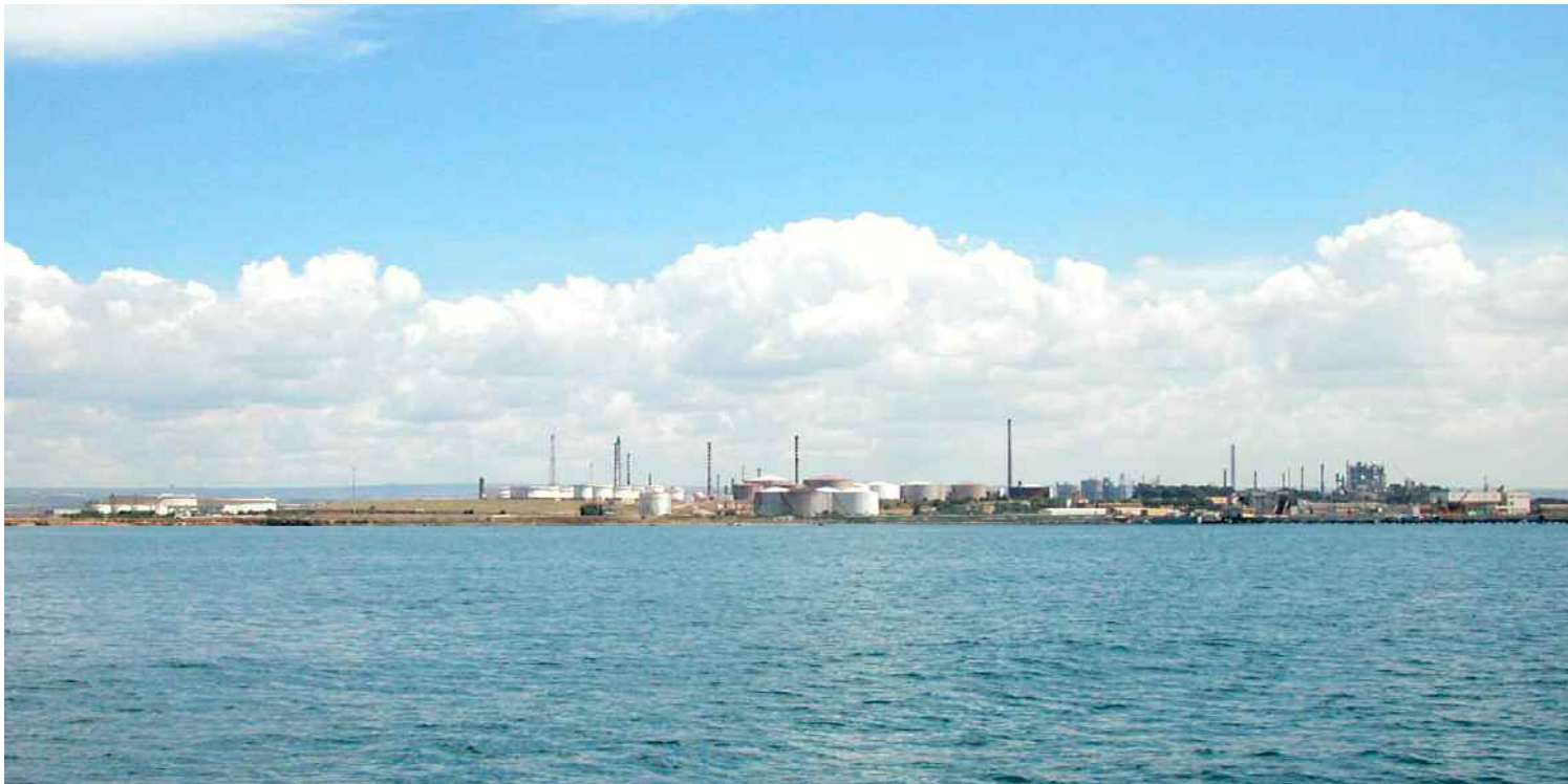
Figura 5.4-11: Mare antistante l'area della raffineria, stato di fatto
