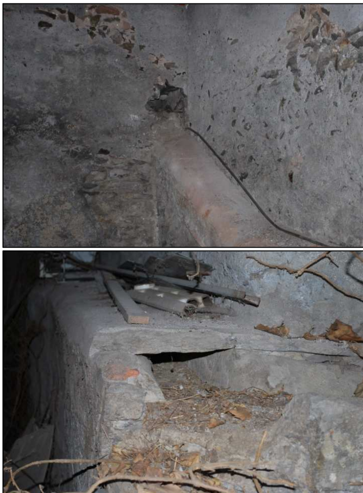
Figura 7 - Canale di derivazione dell'acqua
