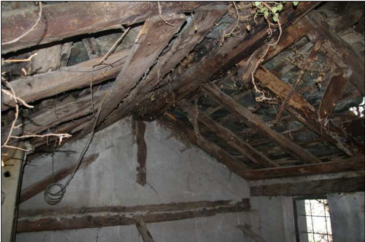
Figura 14 - Particolare della copertura
