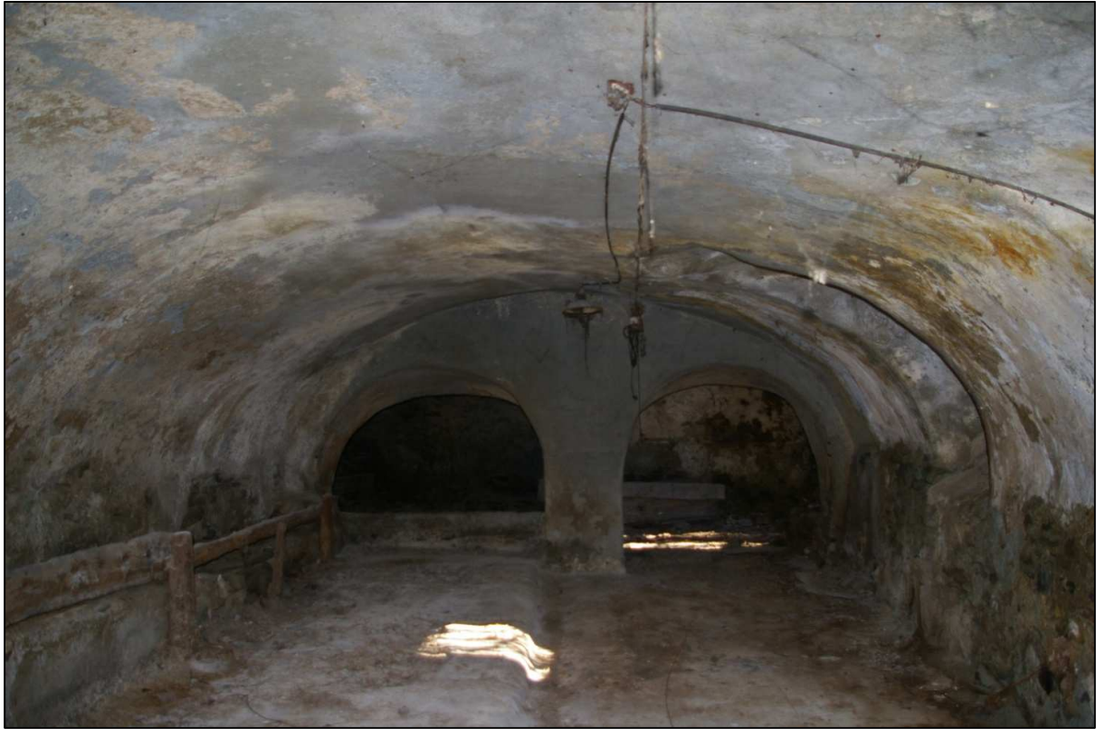
Figura 11 - Locale adibito a stalla
