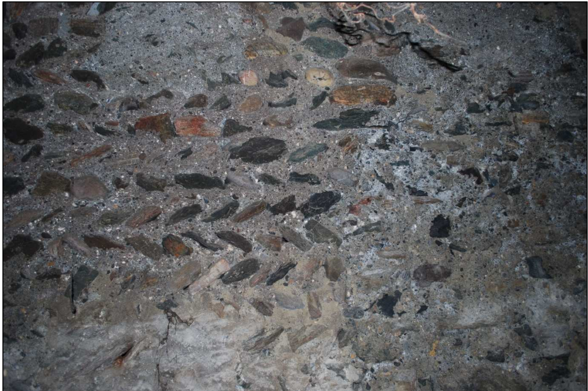
Figura 12 - Dettaglio dell' opus spicatum
