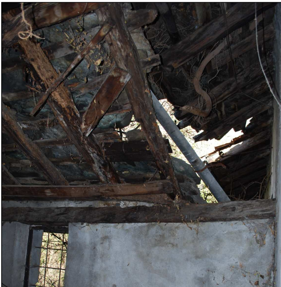
Figura 15 - Particolare della copertura
