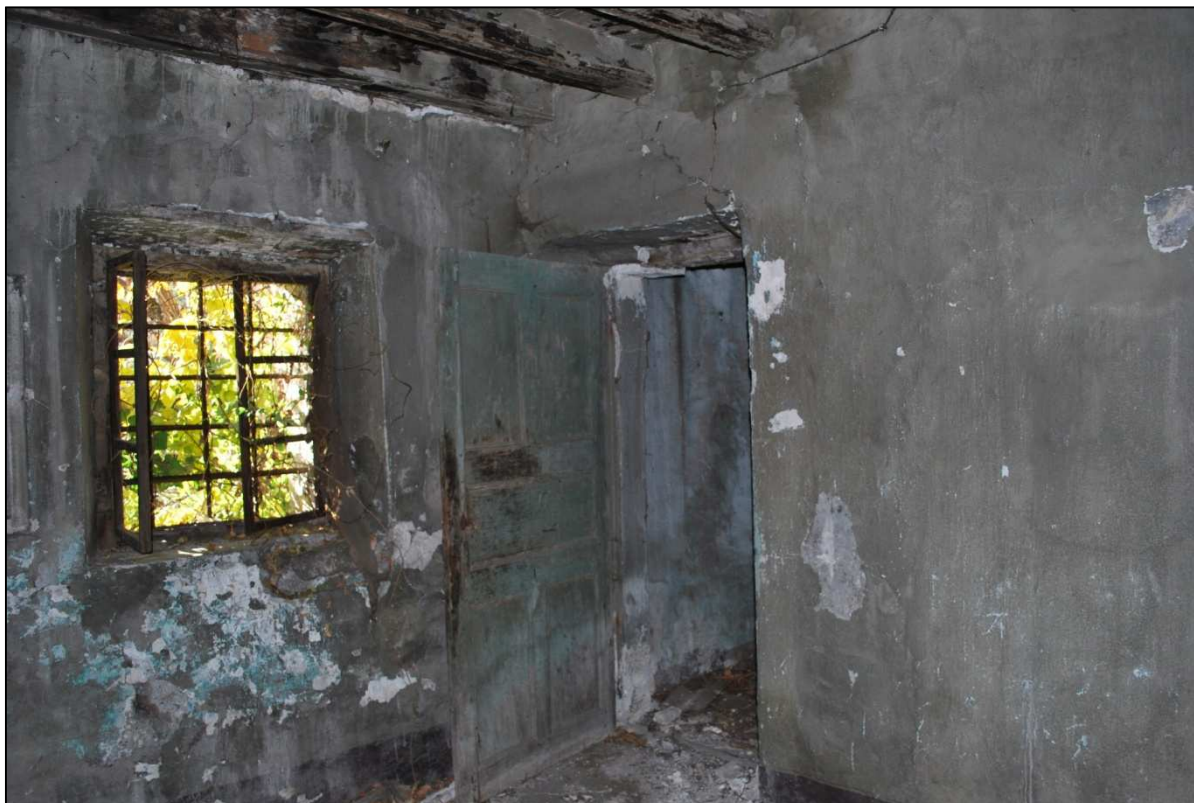
Figura 17 - Locale interno al piano terra
