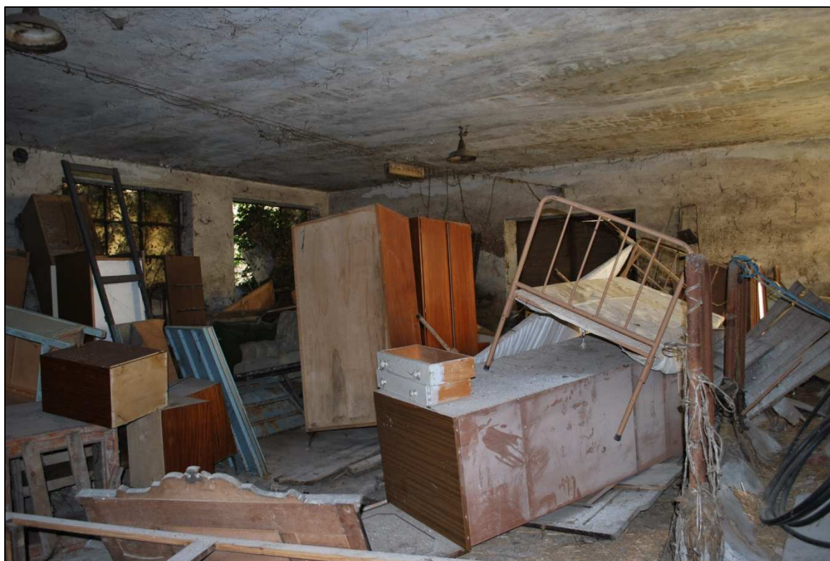
Figura 22 - Interno del locale oggetto di intervento nel XX secolo
