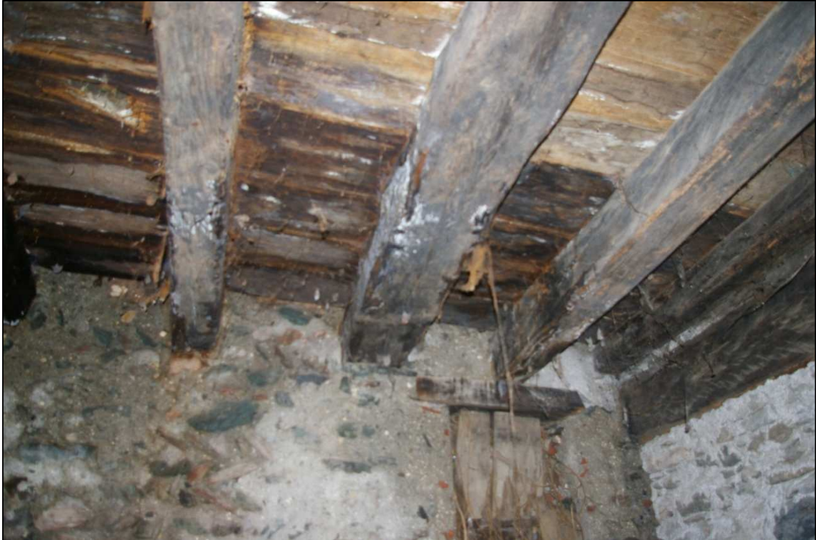
Figura 13 - Dettaglio dei travi di sostegno dei pavimenti
