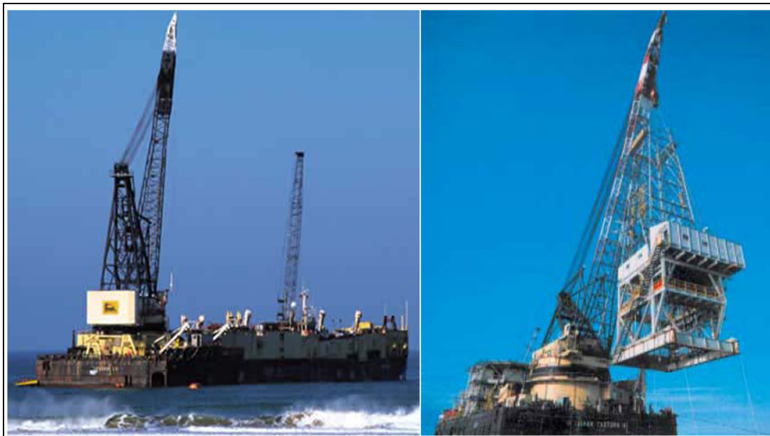
Figura 3-4: immagini del mezzo navale di sollevamento tipo Crane-Barge
