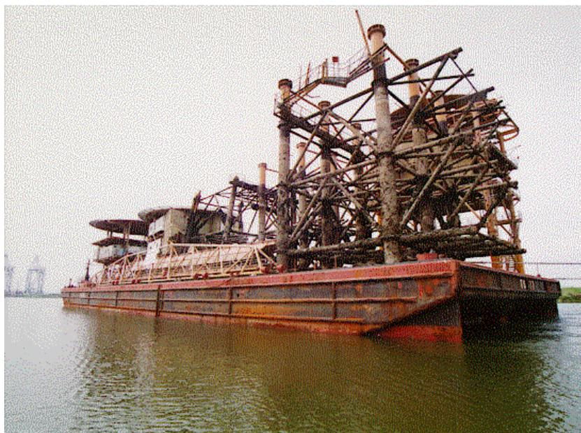
**Figura7. 6 - Trasporto delle Strutture Rimosse**
