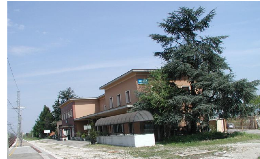
Figura 36– Stato attuale – F.V. e l'accesso al sottopasso esistente: entrambi da demolire
