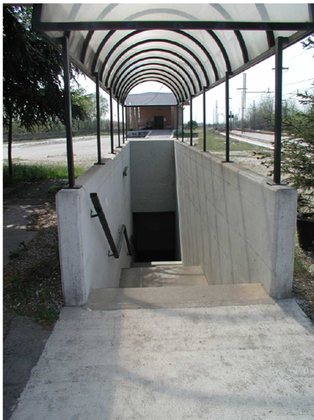
Fig. 6 - Stato attuale – rampa di accesso al sottopasso con copertura di protezione
