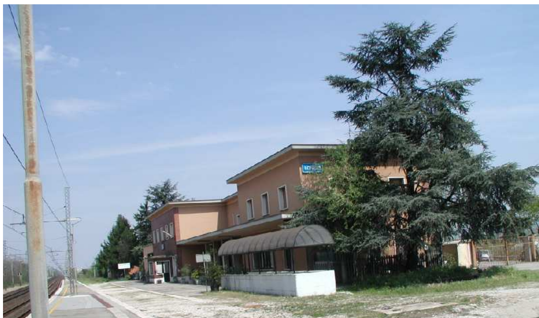
Fig. 3 – Stato attuale – F.V. e l'accesso al sottopasso esistente: entrambi da demolire
