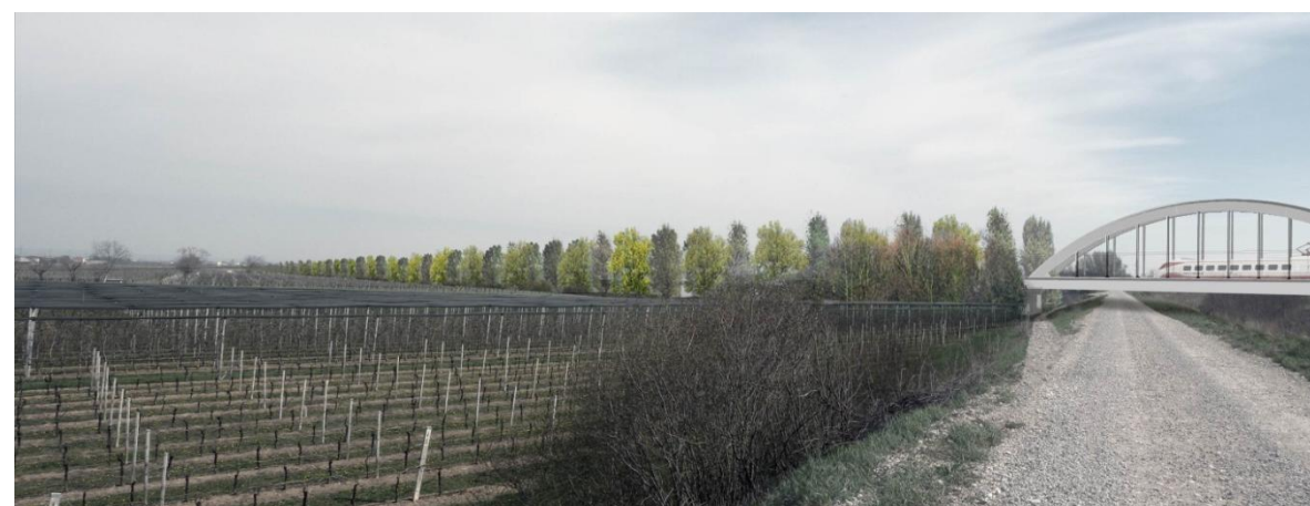
Figura 8 – “Viadotto d’Illasi” Km 11+500 a 11+700 c.a. – Dall’alto verso il basso: 1. Stato ante operam; 2. Fotosimulazione post operam; 3. Fotosimulazione post mitigazione
