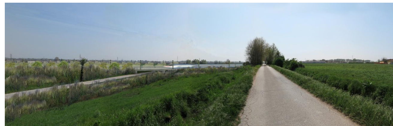
Figura 7 – “Viadotto Fibbio” Km 7+650 a 11+300 – Dall’alto verso il basso: 1. Stato ante operam; 2. Fotosimulazione post operam; 3. Fotosimulazione post mitigazione
