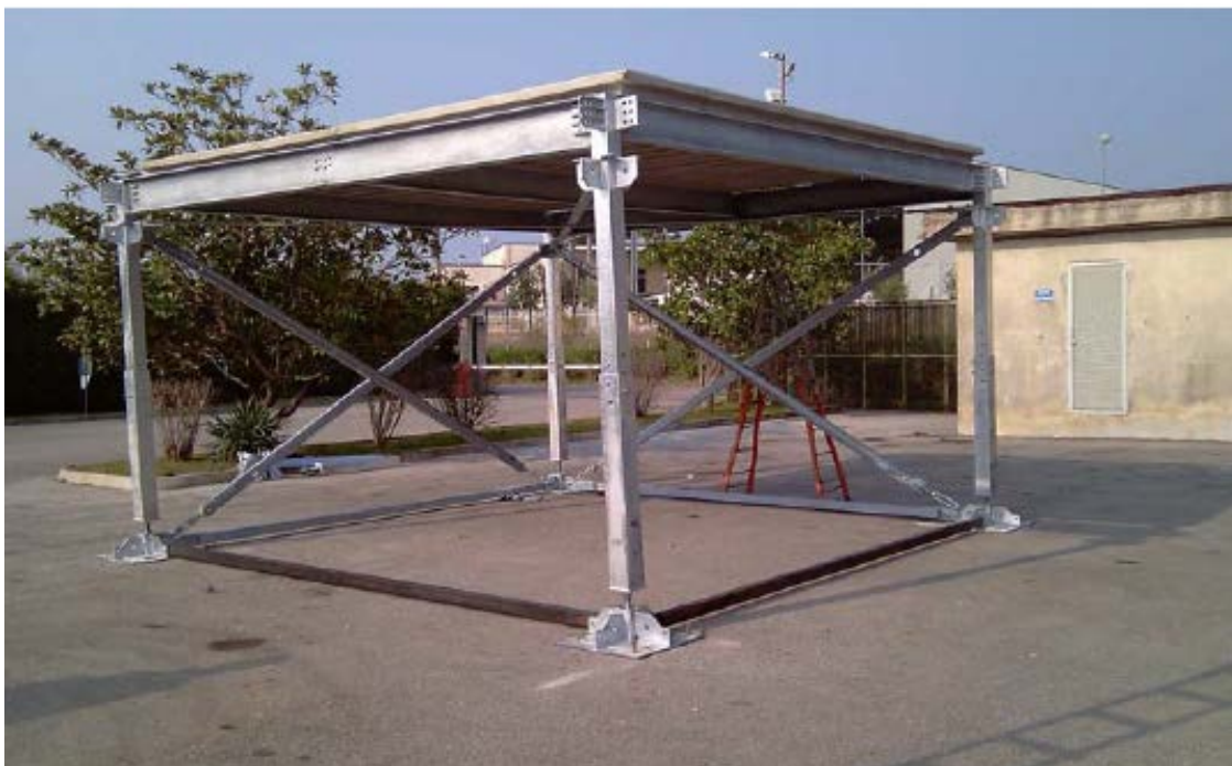
Figura 52 – Esempio di elemento modulare per parcheggio sopraelevato
