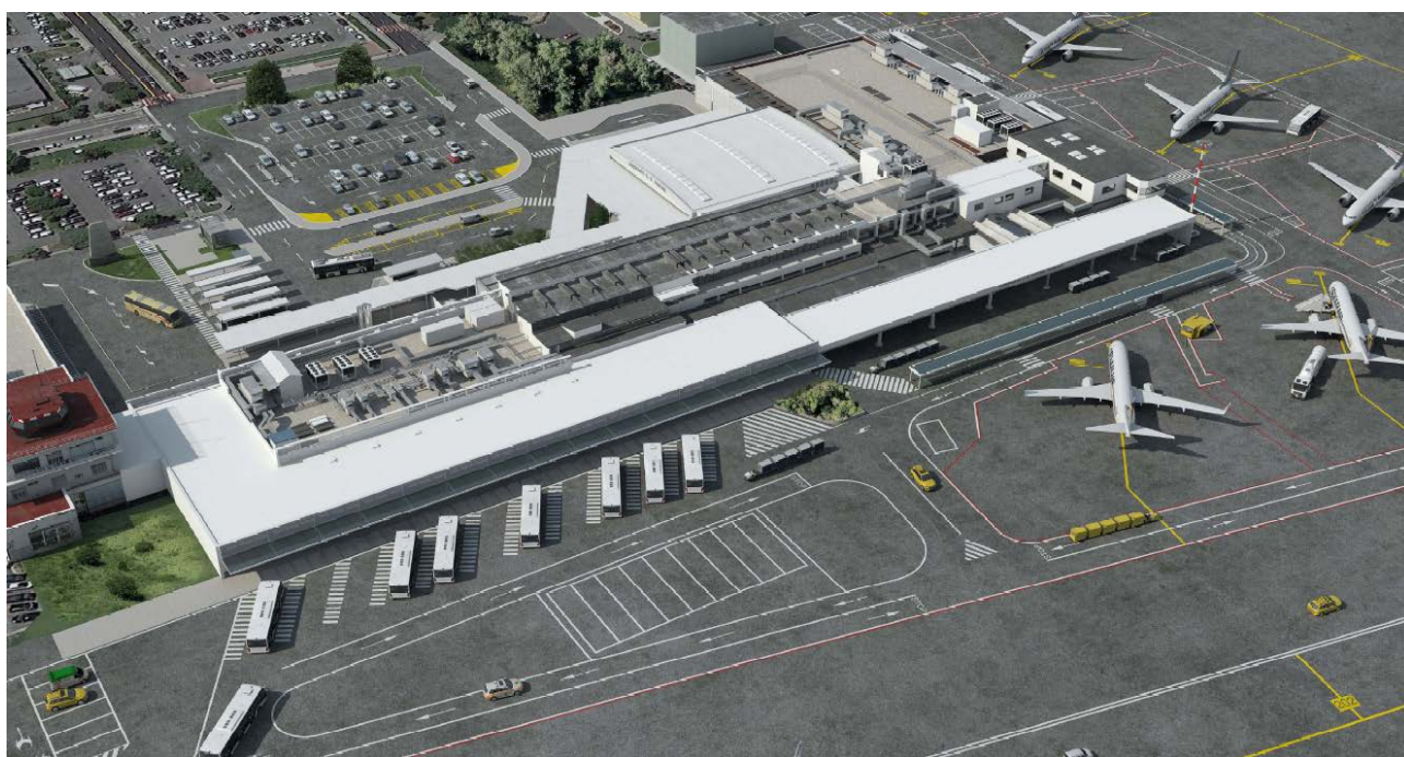
Figura 46 –Vista del Terminal riconfigurato
