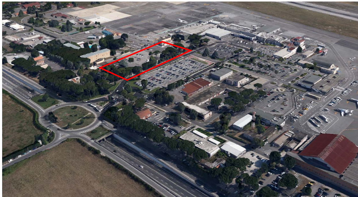
Figura 4.22 – Vista aerea parcheggio P5
