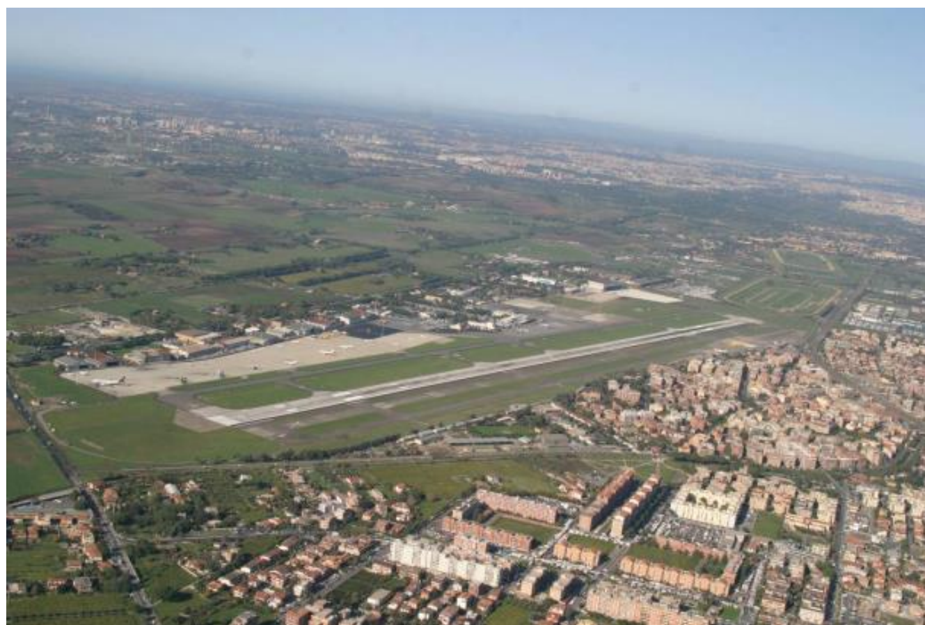
Figura 1.1 vista dall'alto dell'aeroporto di Ciampino
