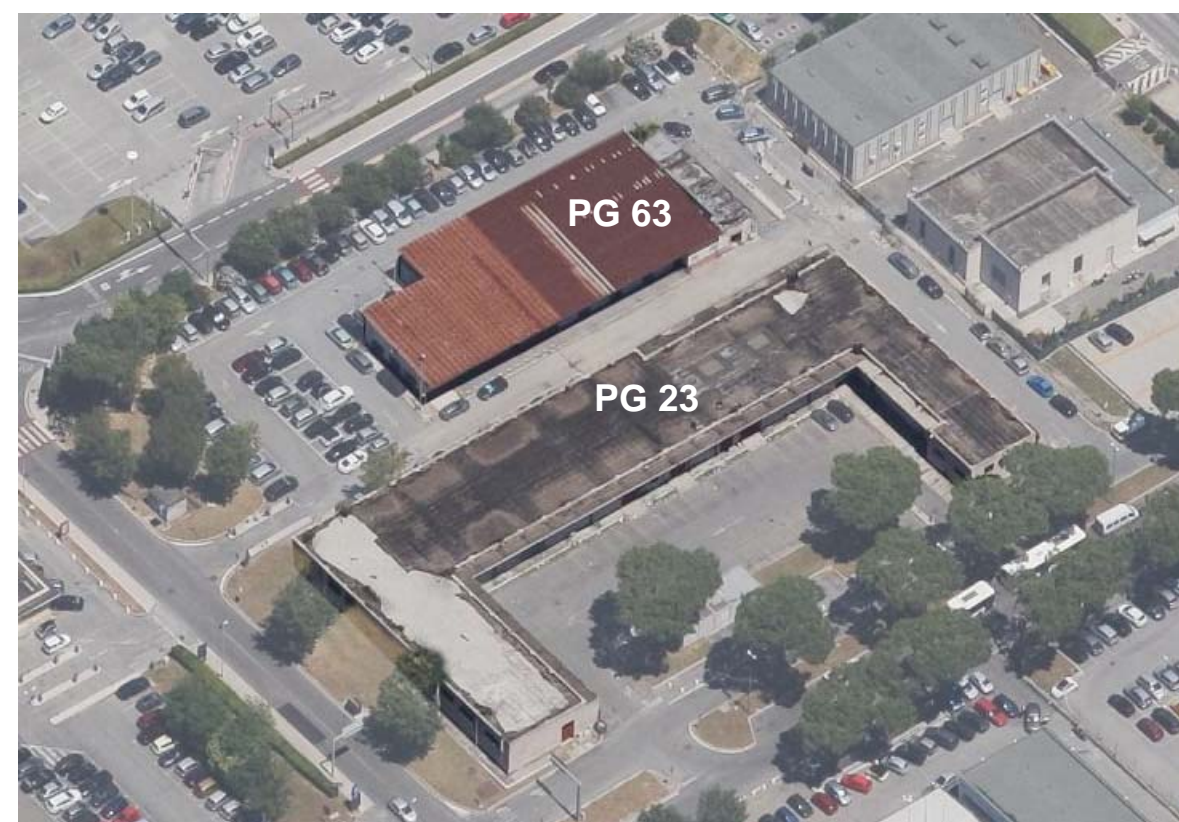
Figura 4.26 – Attuali Edifici PG 23 e PG 63
