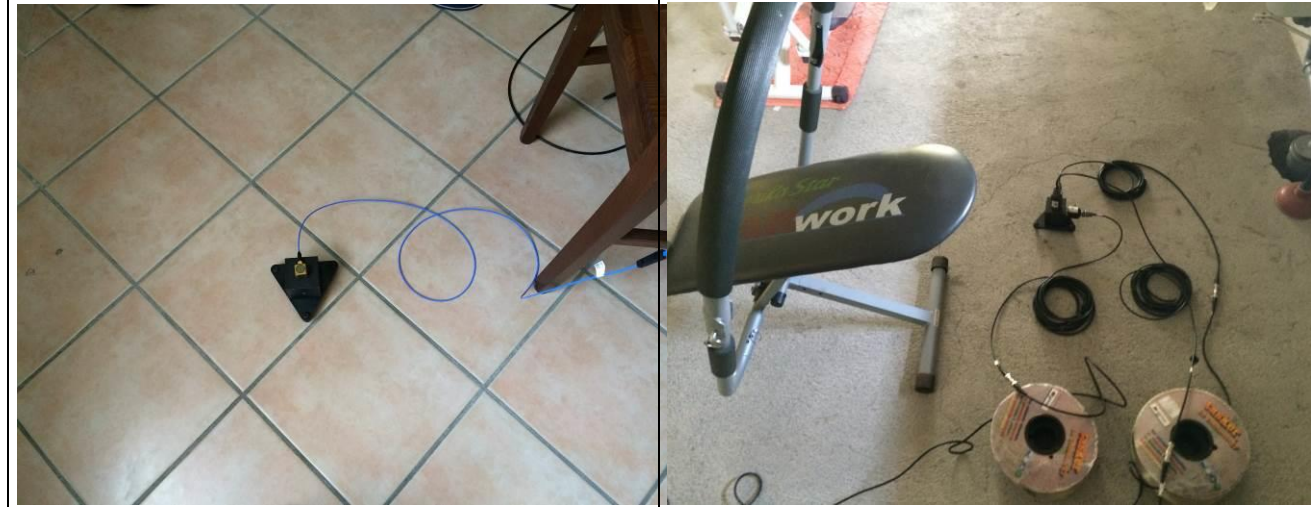
Posizionamento accelerometro triassiale, 1° piano f.t. Posizionamento accelerometri monoassiali, 2° piano f.t.
