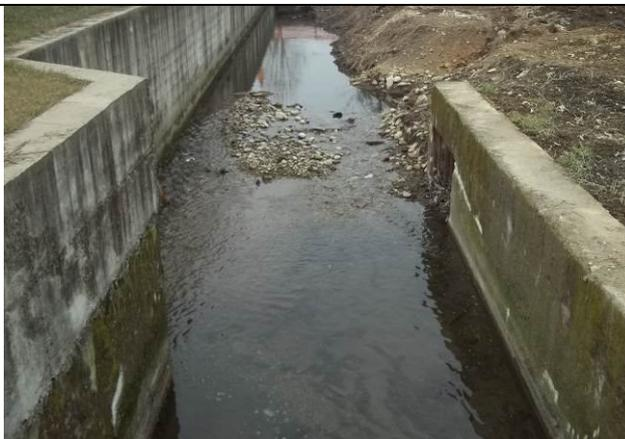
**AV-TG-SU-1-04 – in evidenza alcuni detriti derivanti dalla demolizione del mulino e dagli scavi effettuati nel cantiere limitrofo**
