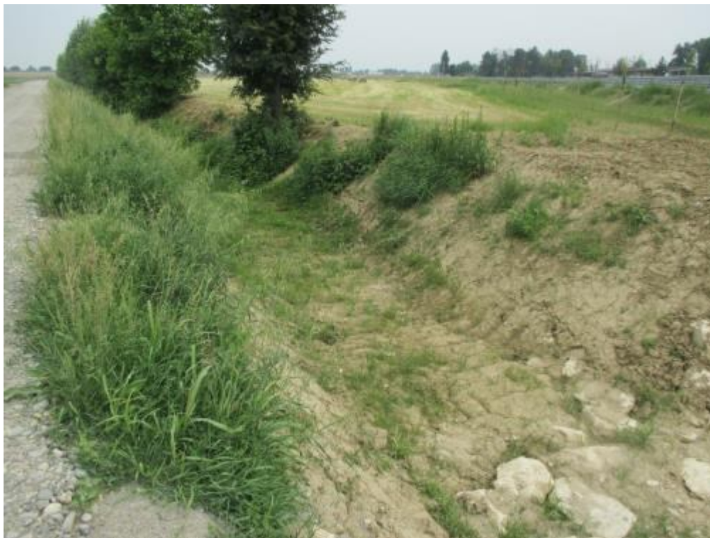
Figura 5.2 Alveo in asciutta della Roggia Stanga
